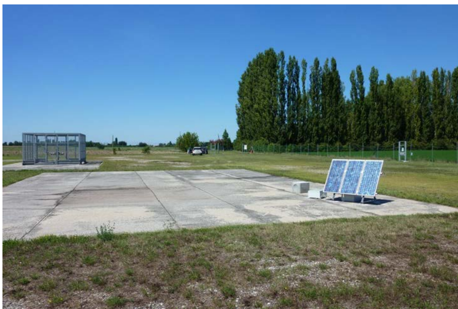
Figura 2 Area di installazione.
