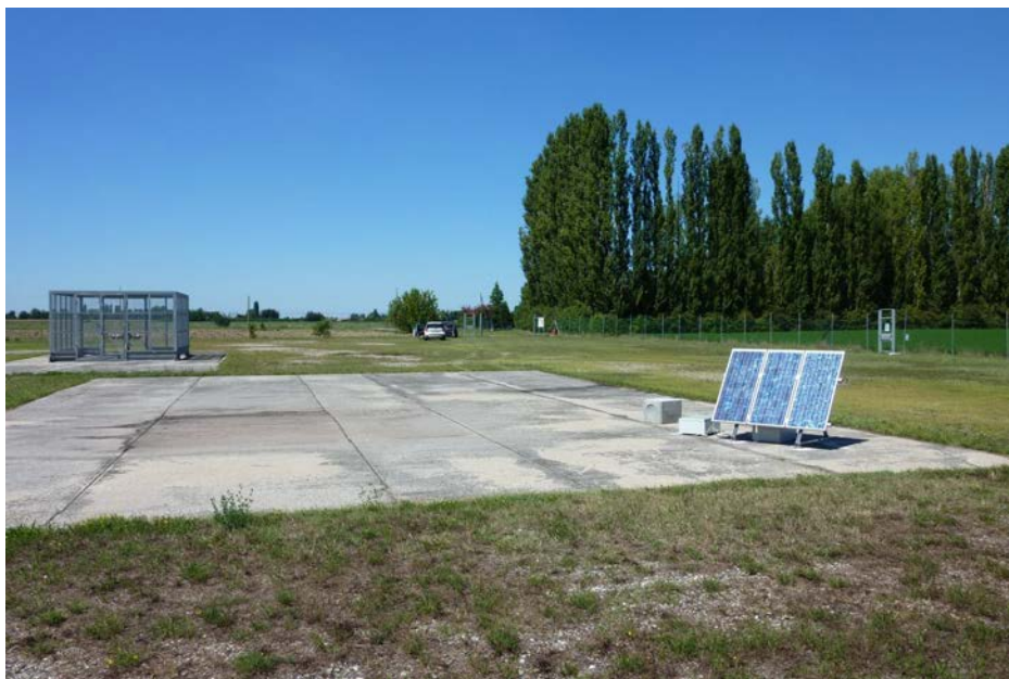
Figura 2 Area di installazione.
