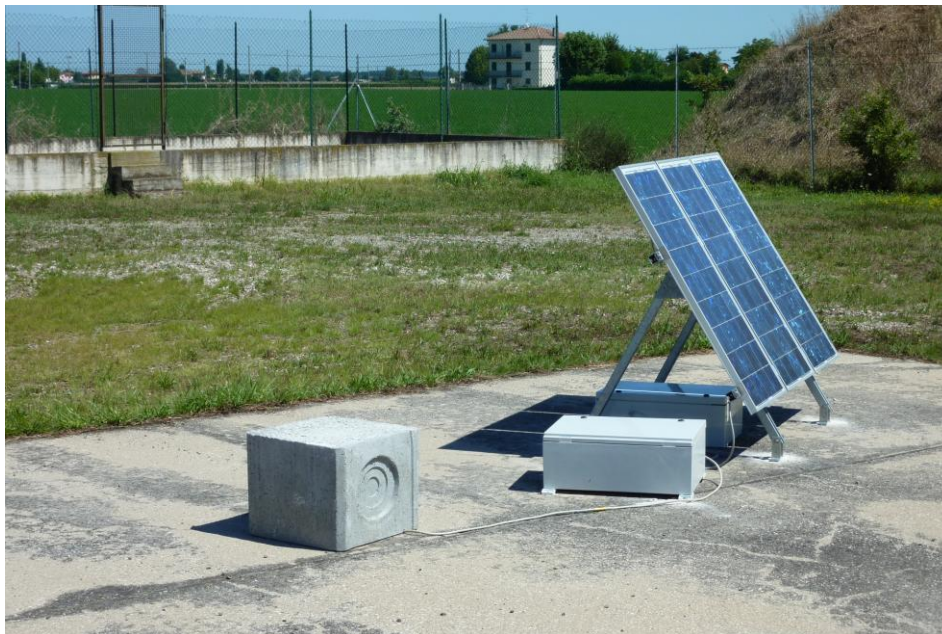
Figura 5 Stazione sismica con apparato di alimentazione.
