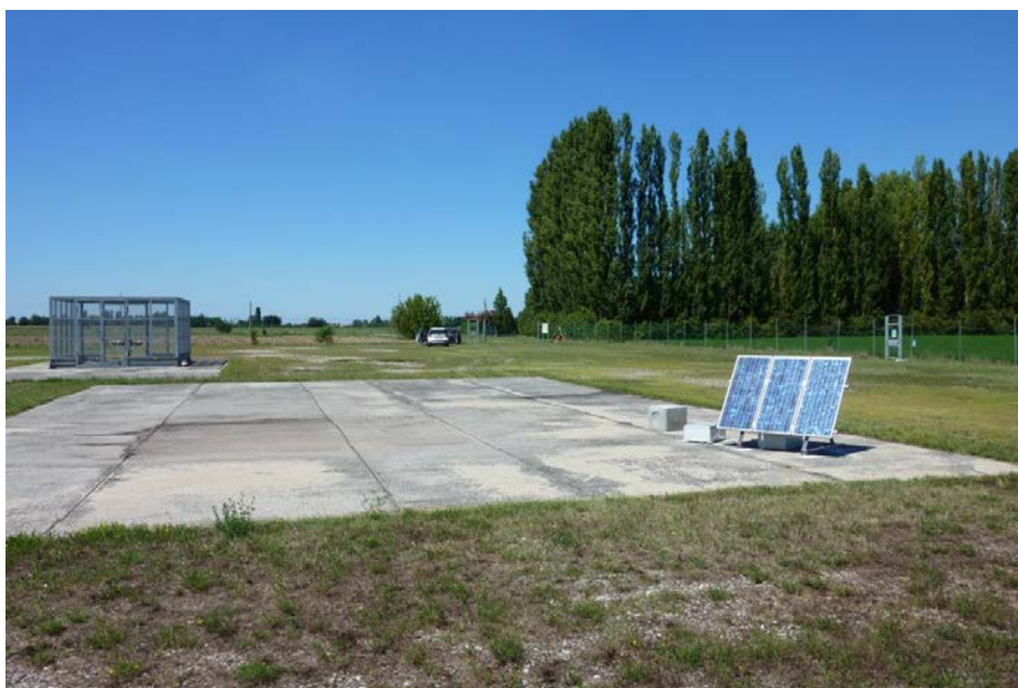
Figura 2 Punto di installazione stazione sismica all'interno dell'area del pozzo S.Maddalena 1dir
