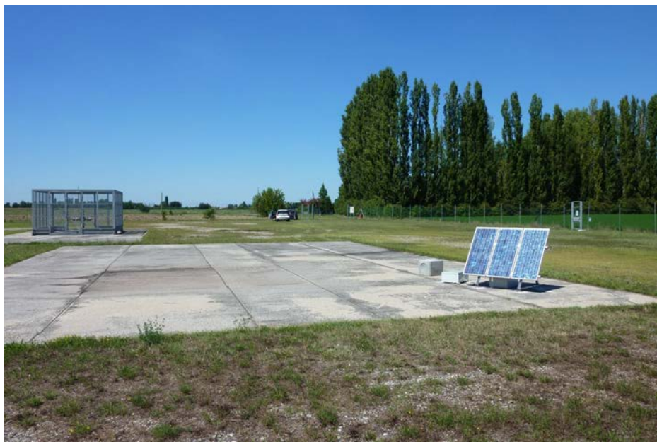
Figura 2 Area di installazione.
