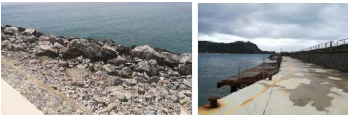
Fig.2 Condizioni della mantellata del molo di sovraflutto ed episodio di tracimazione
