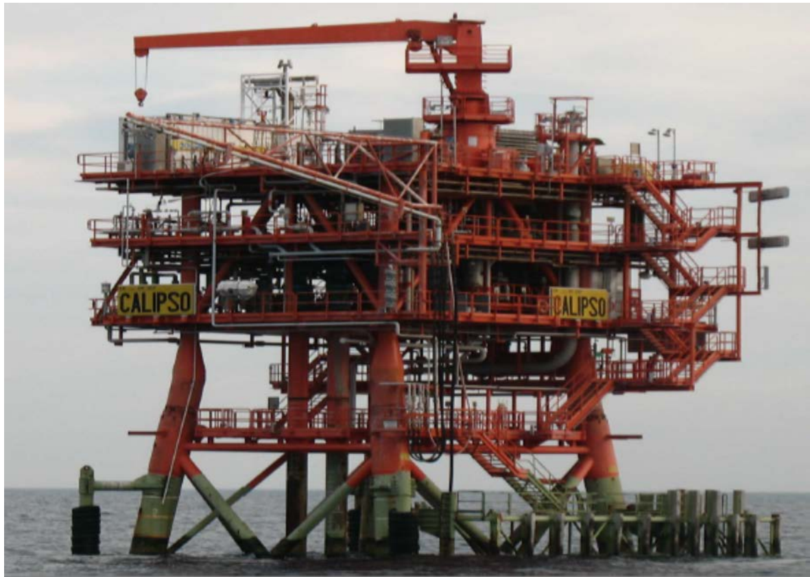
Figura 5 - Sovrastruttura deck Piattaforma Calipso
