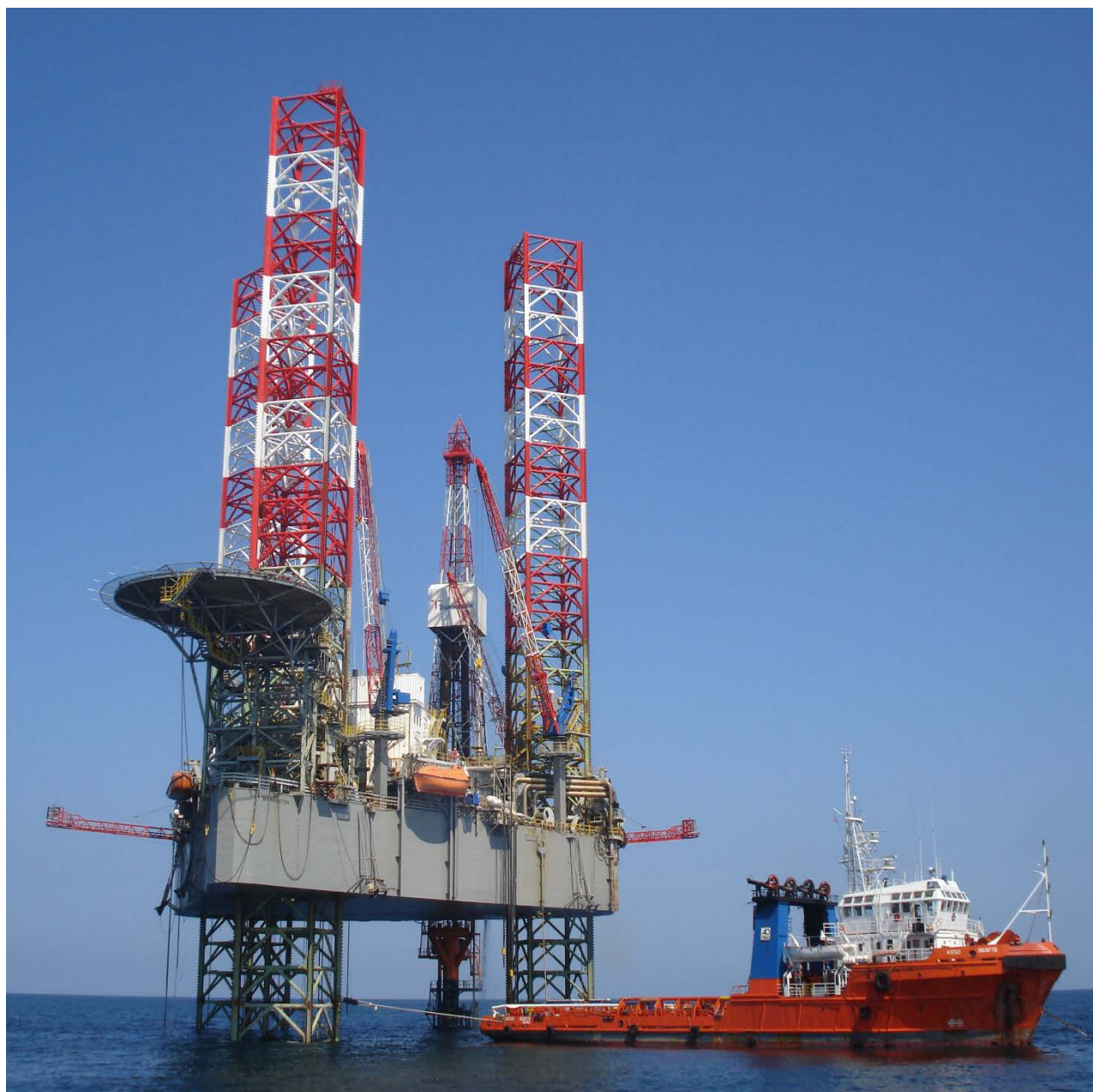
Figura 6 - Impianto Jack-Up Drilling Unit (tipo "GSF Key Manhattan")
