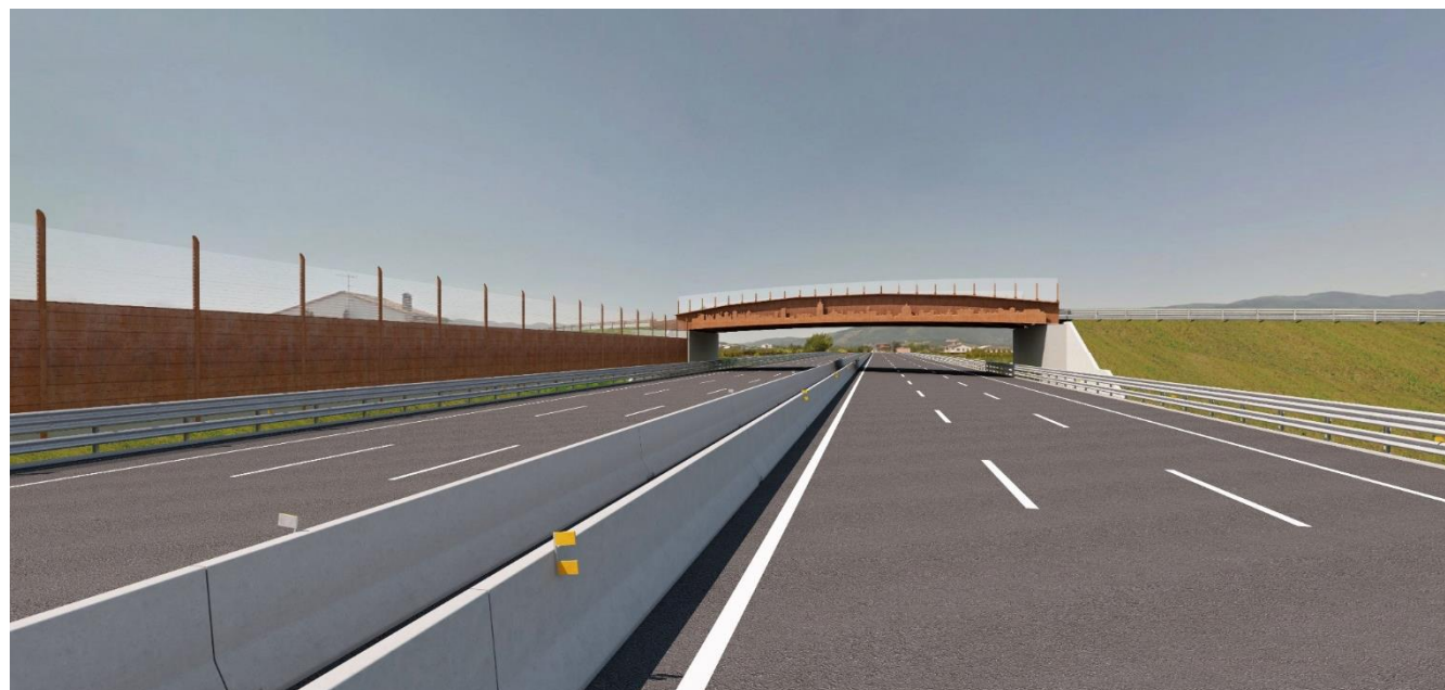
Vista 2, stato post operam diurno, direzione Pisa (mare)
