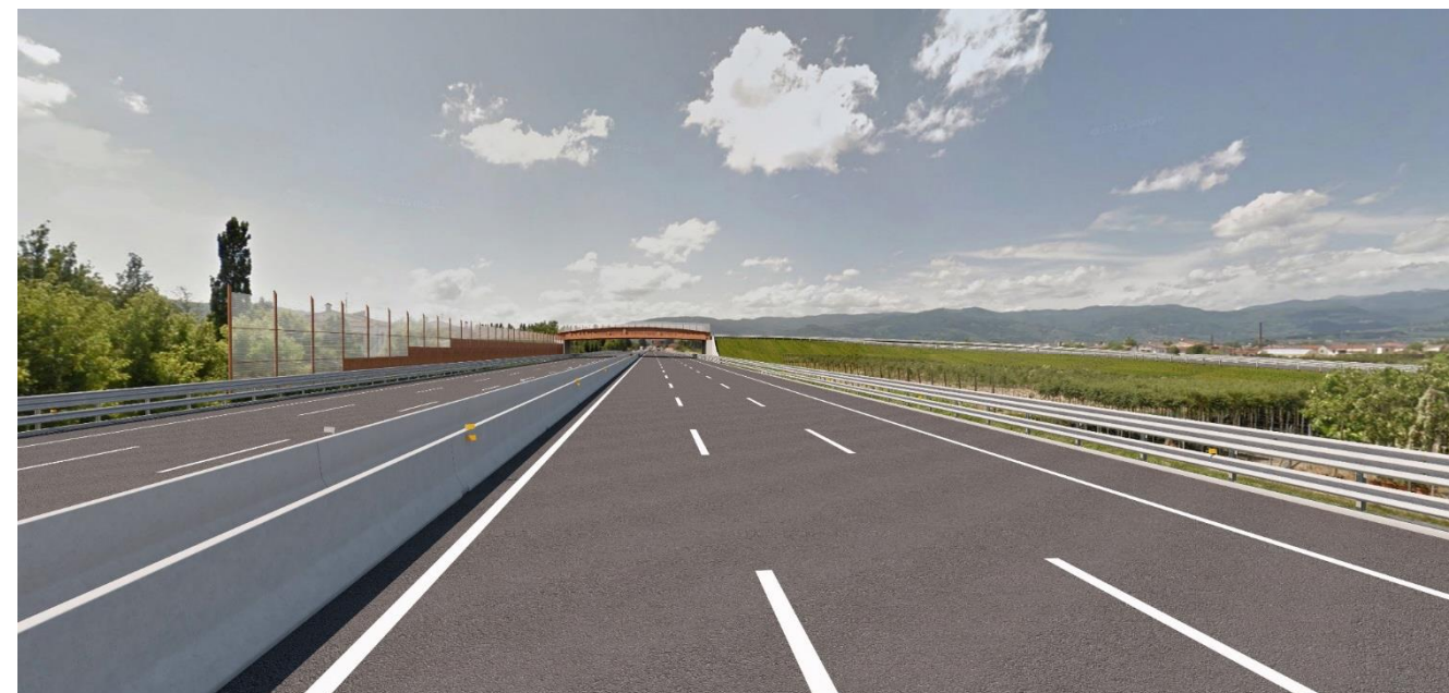
Vista 1, stato post operam diurno, direzione Pisa (mare)
