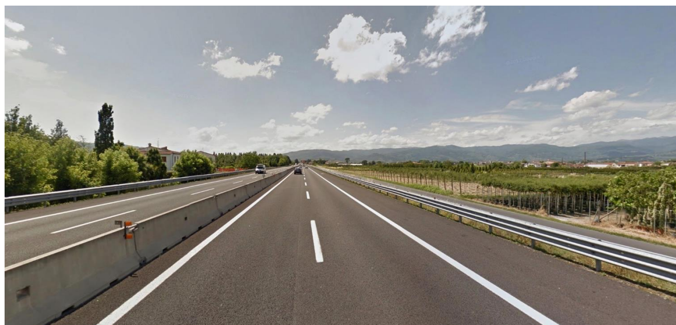
Vista 1, stato ante operam diurno, direzione Pisa (mare)
