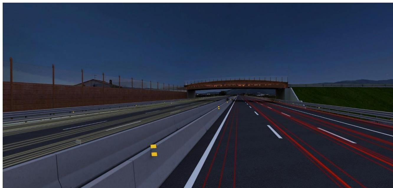
Vista 2, stato post operam notturno, direzione Pisa (mare)
