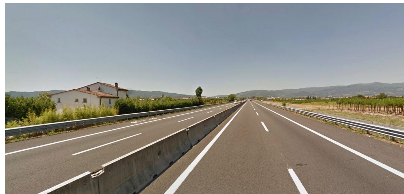
Vista 2, stato ante operam diurno, direzione Pisa (mare)
