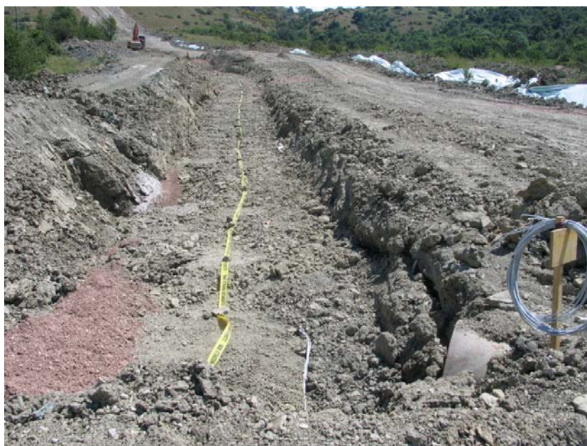
Fig. 3.1.G: Esempio di rinterro della condotta
