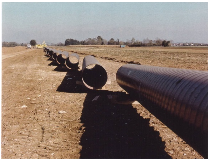
Fig. 3.1.C: Esempio di sfilamento tubazioni
