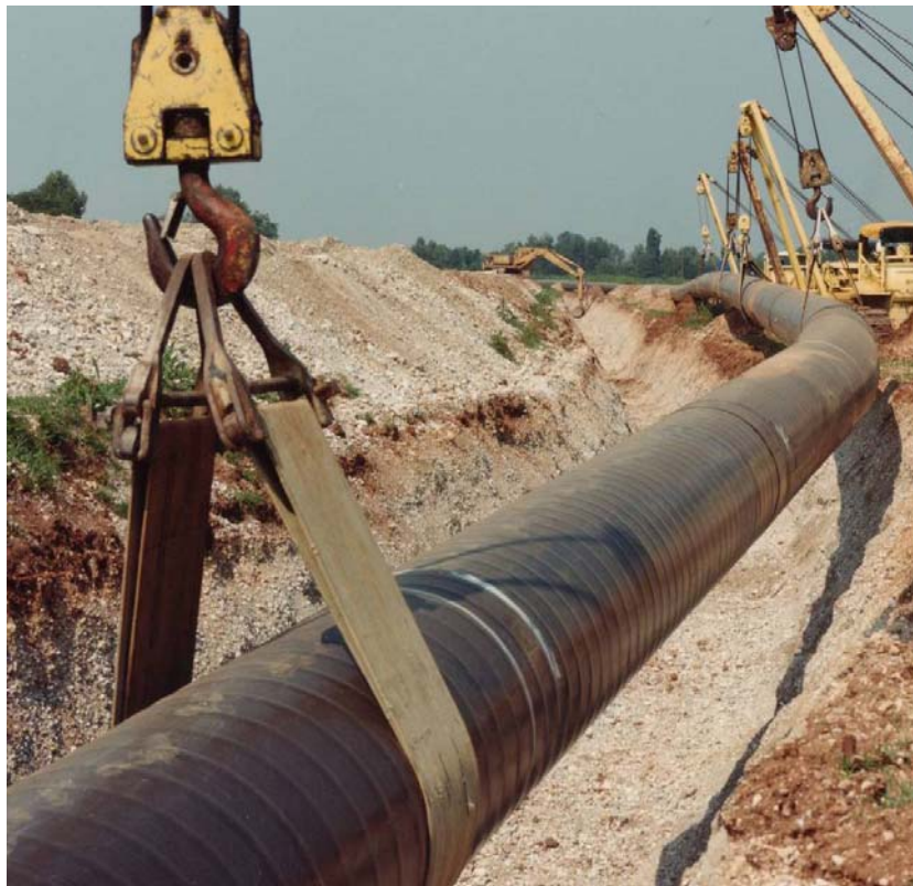
Fig. 3.1.F: Esempio di posa della condotta
