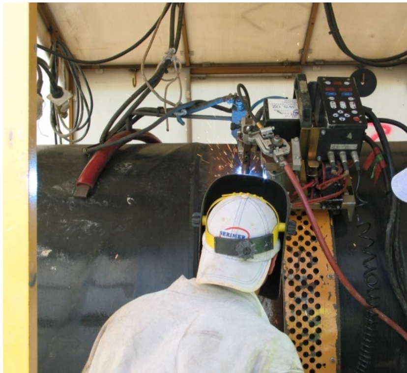
Fig. 3.1.D: Esempio di saldatura di linea
