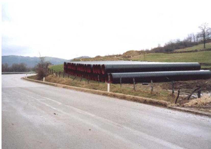
Fig. 3.1.A: Esempio di piazzola di accatastamento tubazioni
