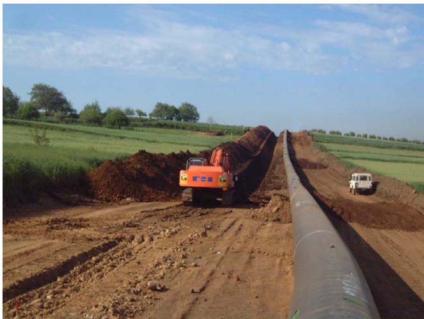
Fig. 3.1.E: Esempio di scavo in trincea
