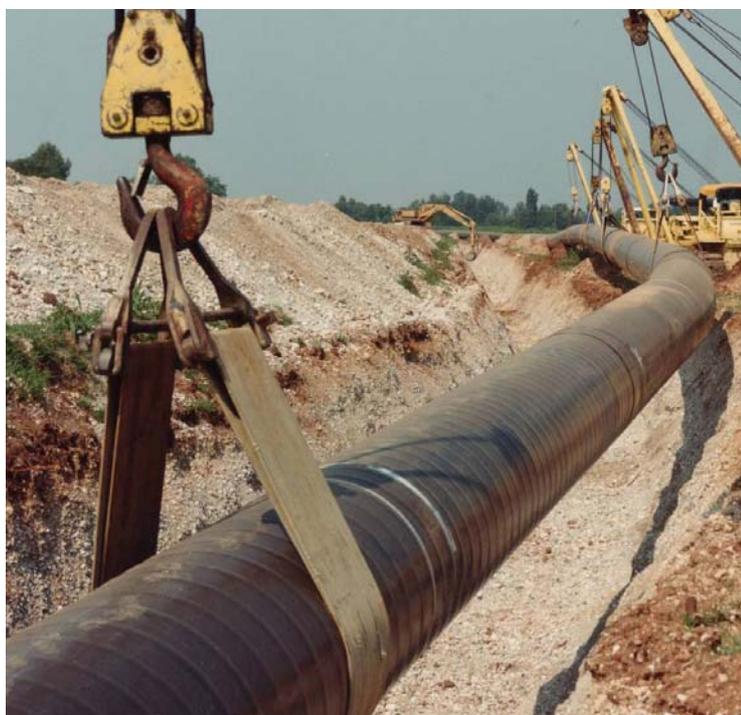
**Figura 3/E: Esempio di posa della condotta**
