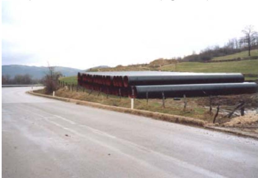
**Figura 3/A: Esempio di piazzola di accatastamento tubazioni**
