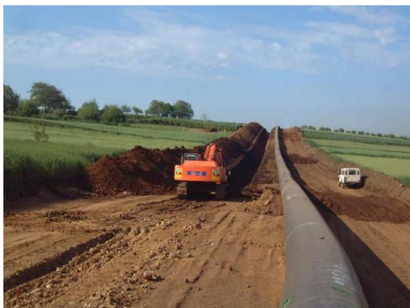
**Figura 3/D: Esempio di scavo in trincea**
