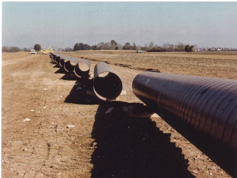
**Figura 3/C: Esempio di sfilamento tubazioni**
