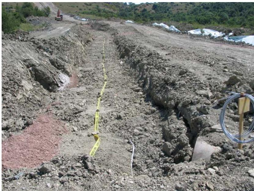
**Figura 3/F: Esempio di rinterro della condotta**
