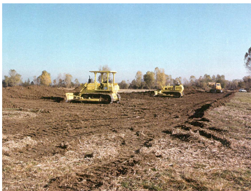
Fig. 2/B: Esempio di apertura dell'area di passaggio
