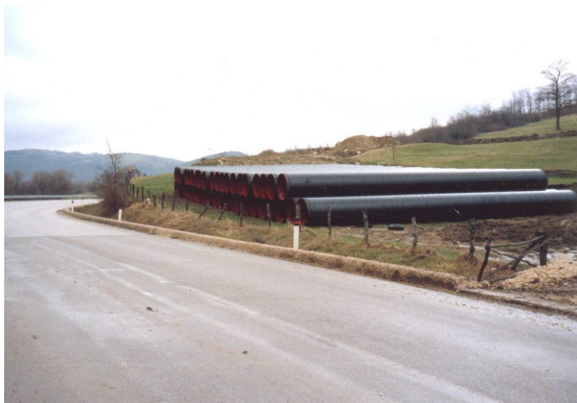
Fig. 2/A: Esempio di piazzola di accatastamento tubazioni
