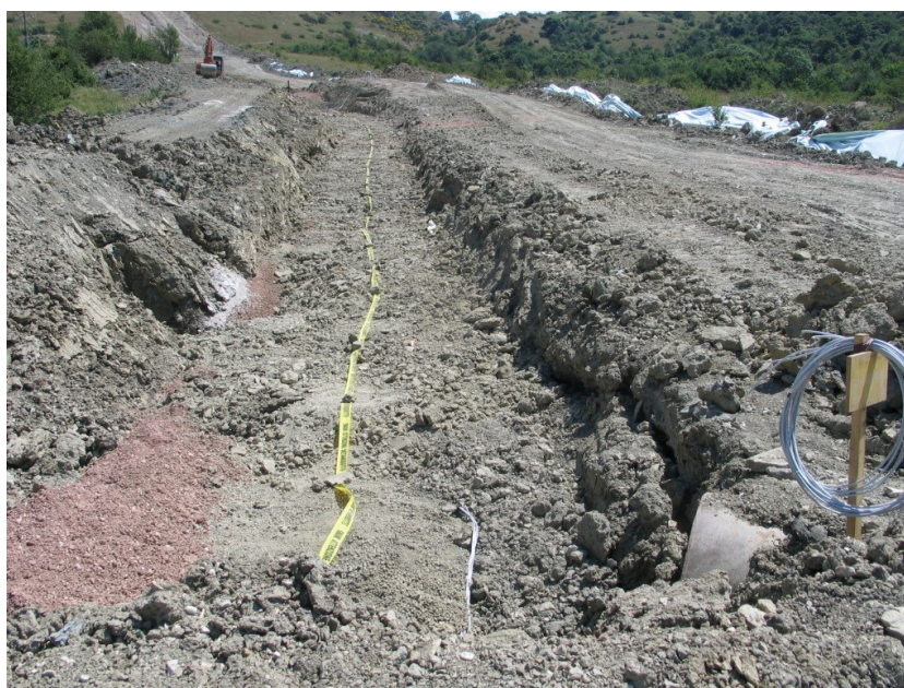
Fig. 2/E: Esempio di rinterro della condotta
