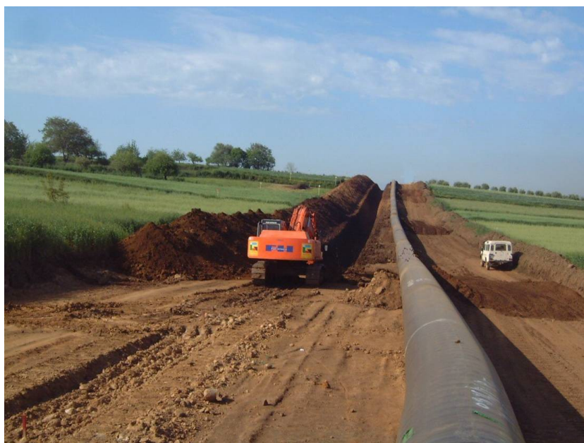
Fig. 2/C: Esempio di scavo in trincea
