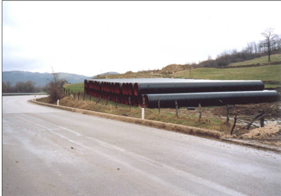
Fig. 3.1.A: Esempio di piazzola di accatastamento tubazioni
