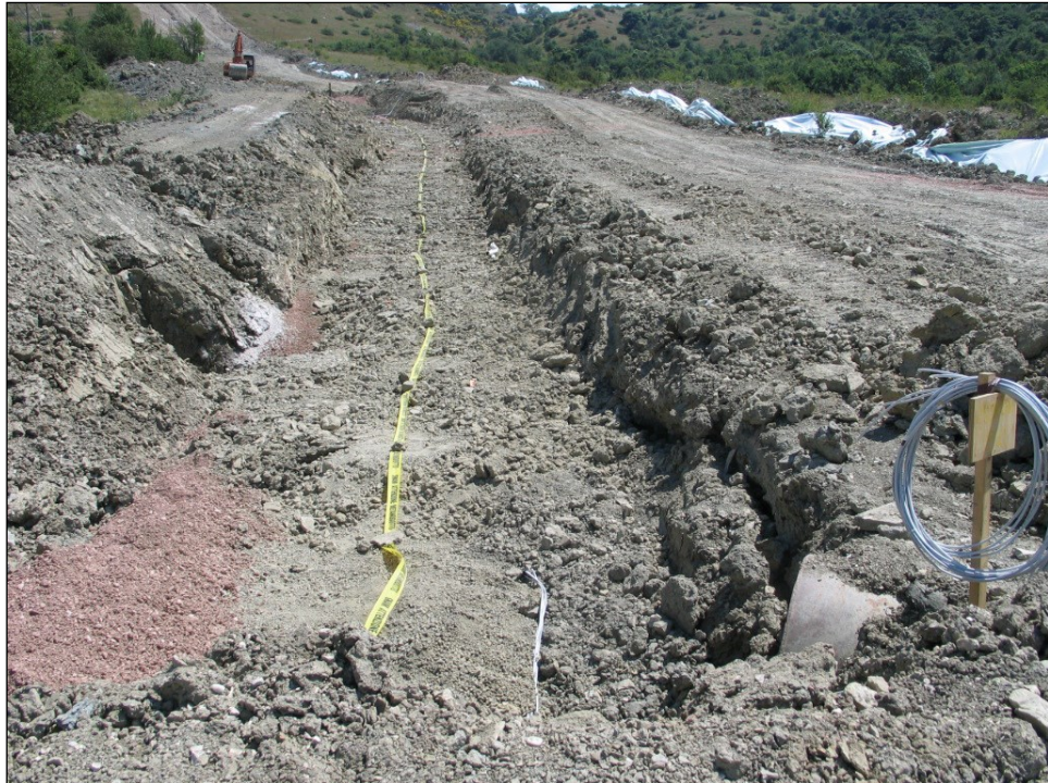
Fig. 3.1.G: Esempio di rinterro della condotta
