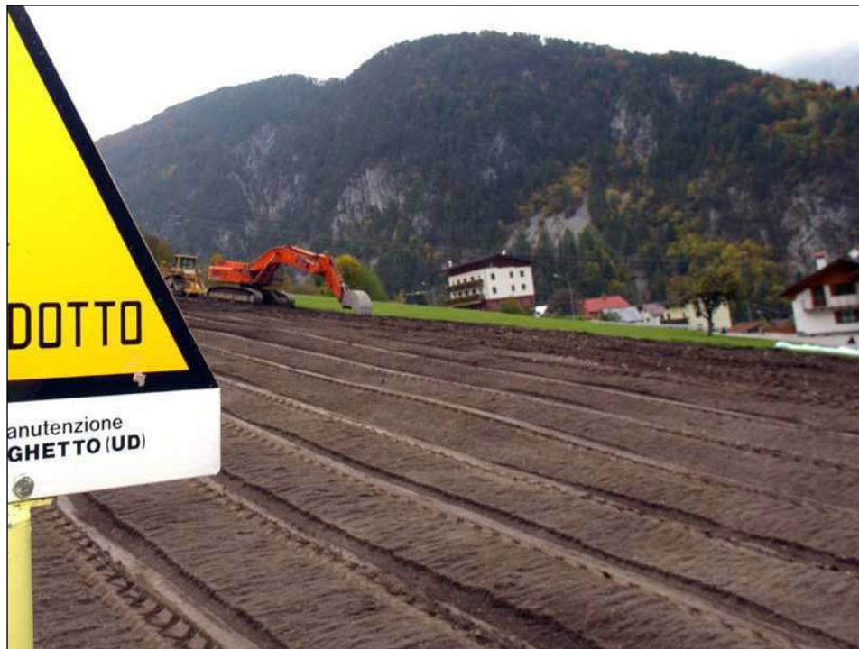
Fig. 3.1.H: Esempio di redistribuzione dello strato superficiale di suolo (topsoil)
