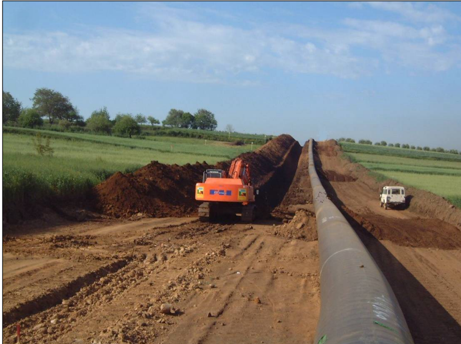
Fig. 3.1.E: Esempio di scavo in trincea
