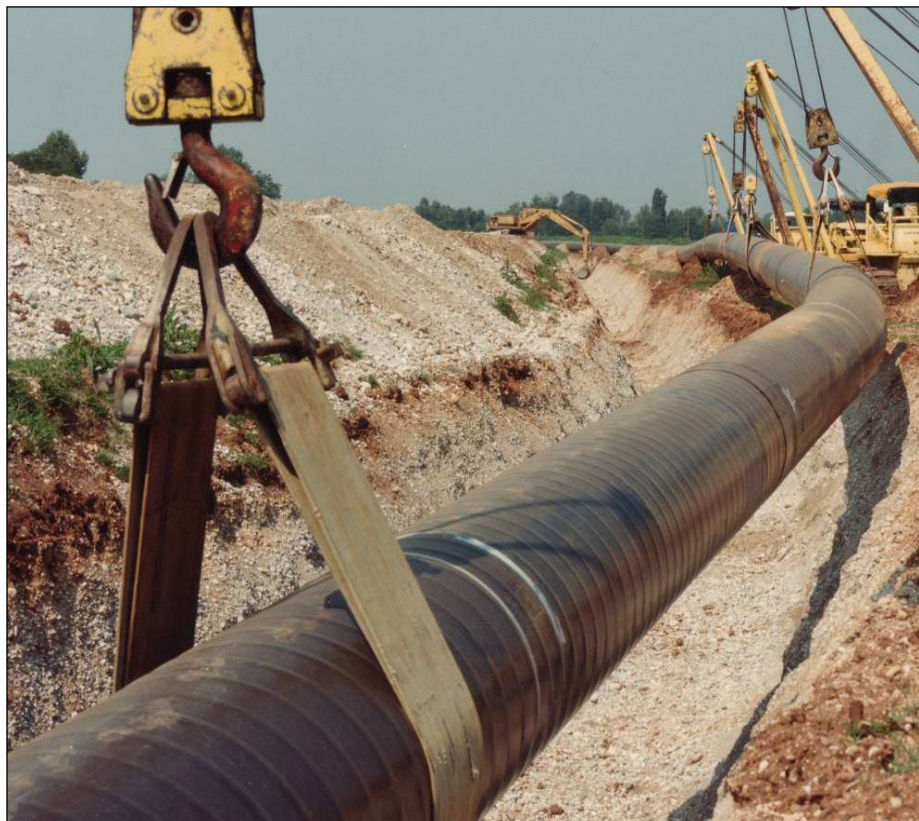
Fig. 3.1.F: Esempio di posa della condotta
