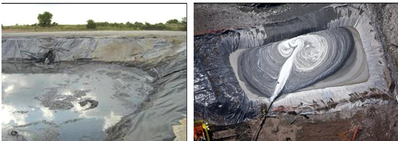
Figg. 25, 26 - Vasche di scarti petroliferi. La foto a sinistra mostra il telo di impermeabilizzazione della vasca lacerato, con conseguente contaminazione del suolo.
