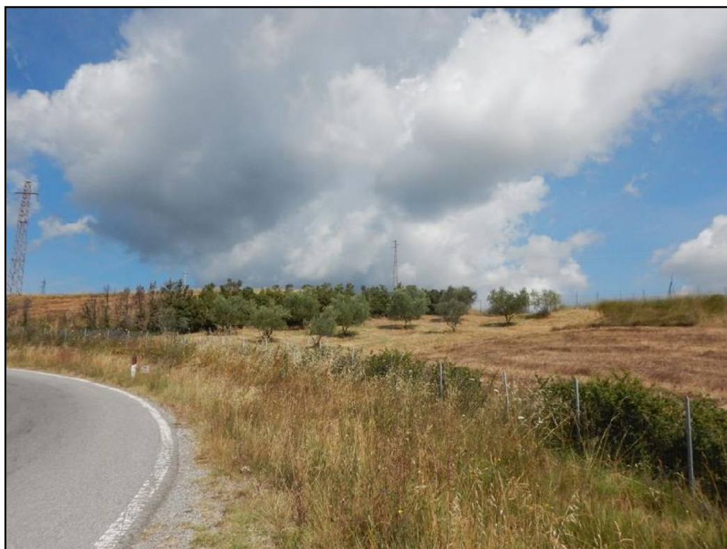
Figura 19 Linea MT in progetto, terzo tratto, proprietà privata. Da SE
