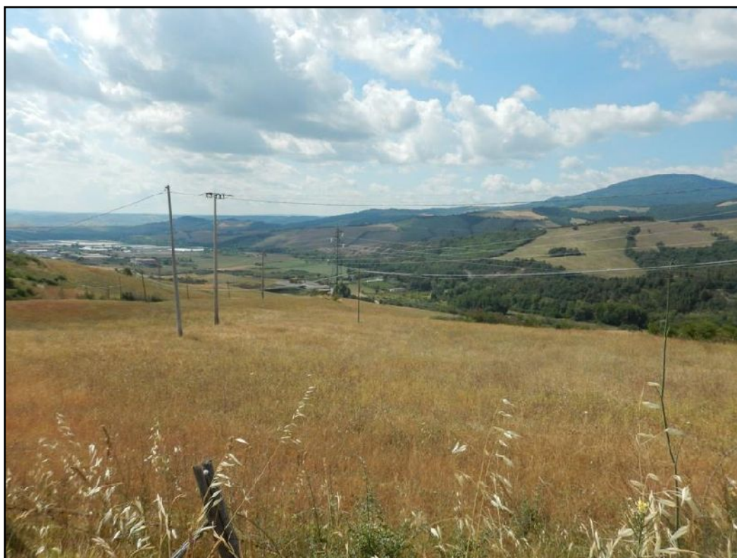
Figura 5 Area Linea MT in progetto, primo tratto, vista da Nord
