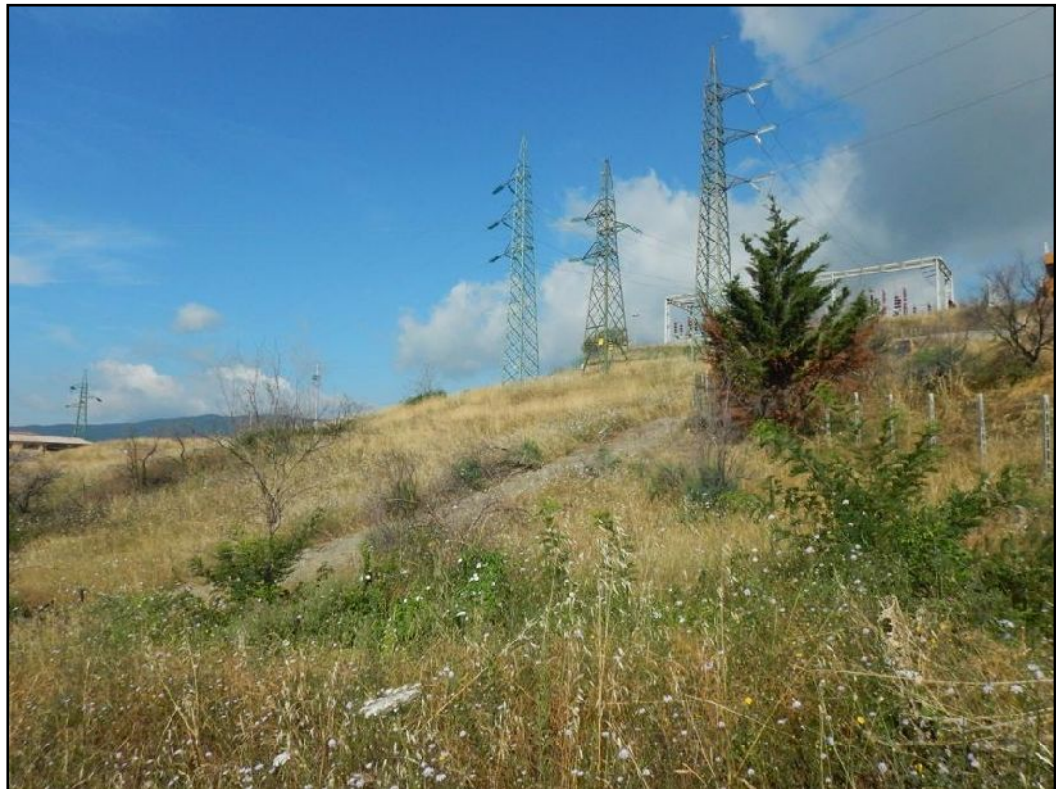
Linea MT in progetto, quarto tratto, centrale Enel Piancastagnaio. Da NW
