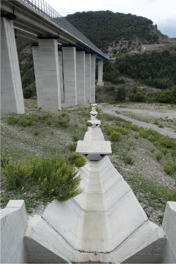
Il rimodellamento delle pendici, particolarmente incisivo per estensione e impatto sul lato in Sx del vallone alla cui base scorre il corso del Noce, è stato necessario per le complesse lavorazioni sui piloni esistenti che sono stati adeguati alle nuove caratteristiche del viadotto.
