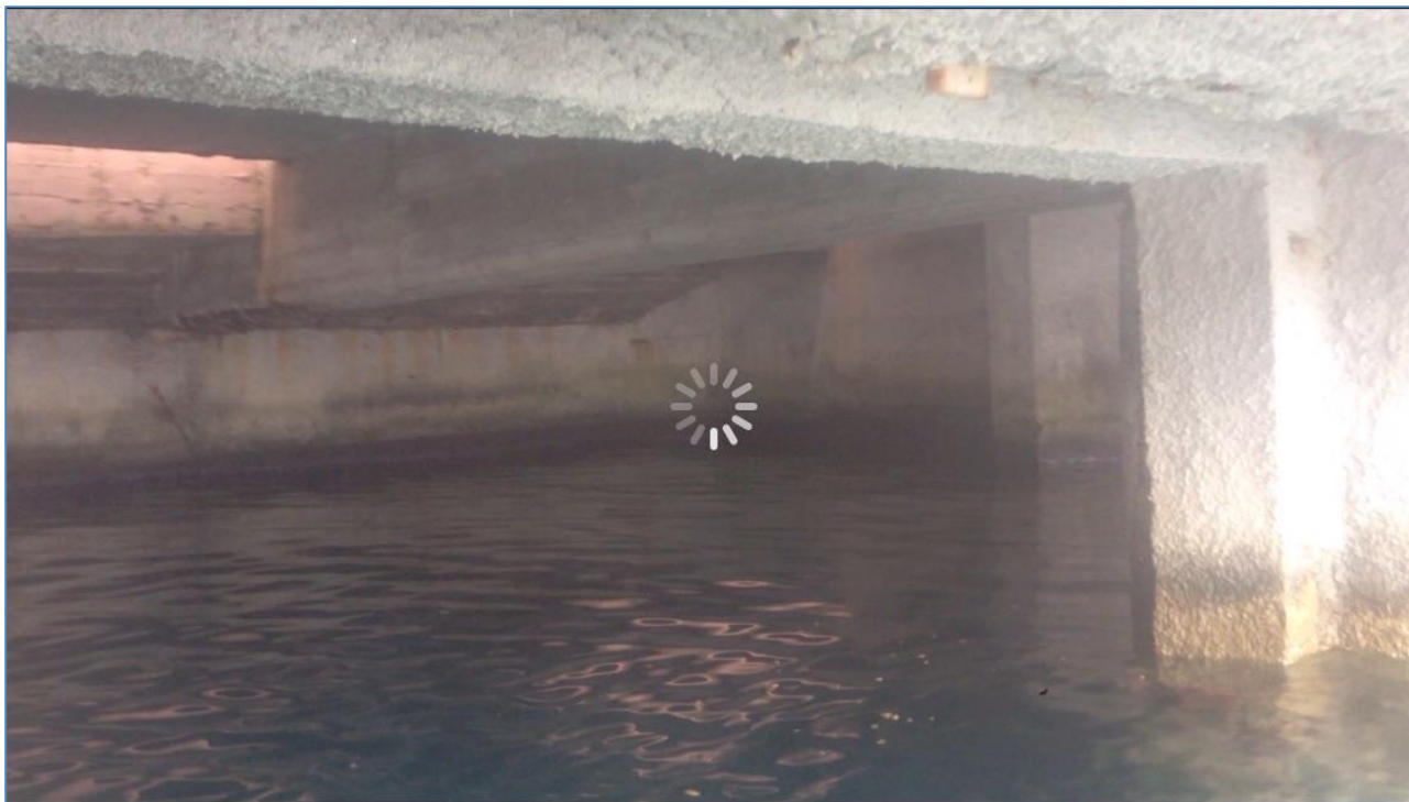
Figura 5 Interno della struttura in c.a.
