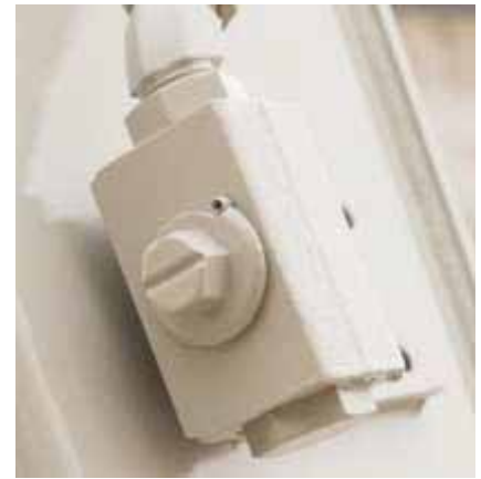
Rubinetti aperti/chiusi all'uscita dell'impianto ausiliario per evitare spillamenti e perdite di pressione in fase di installazione/disinstallazione attrezzature.
