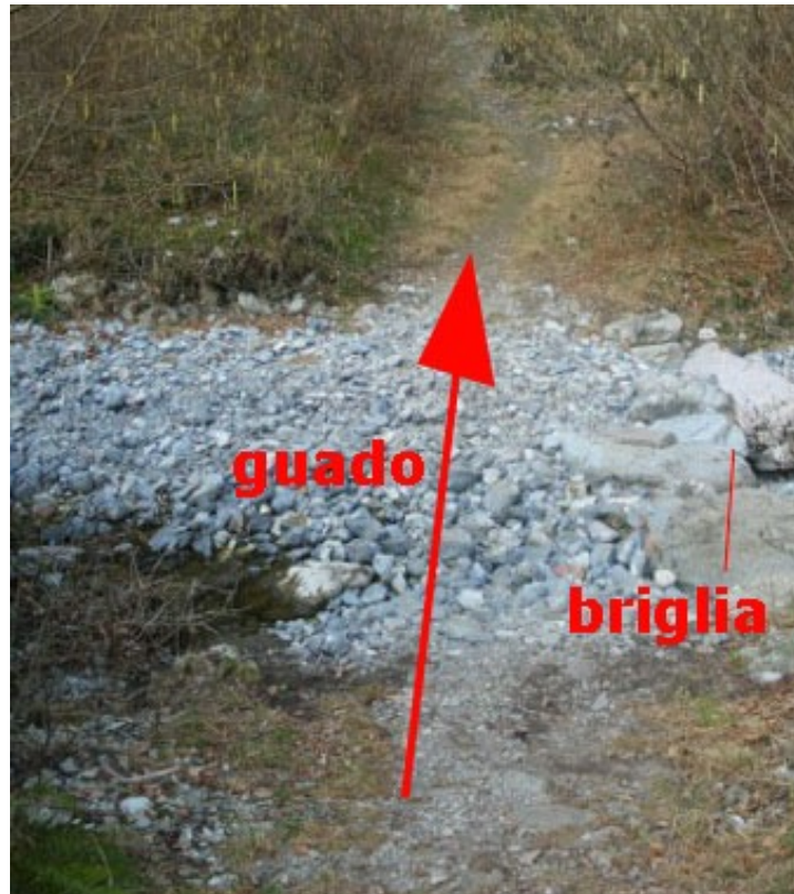
Particolari costruttivi della briglia
