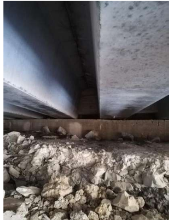
Figura 7-8 – Travetto deteriorato e Dettaglio appoggio travi.
