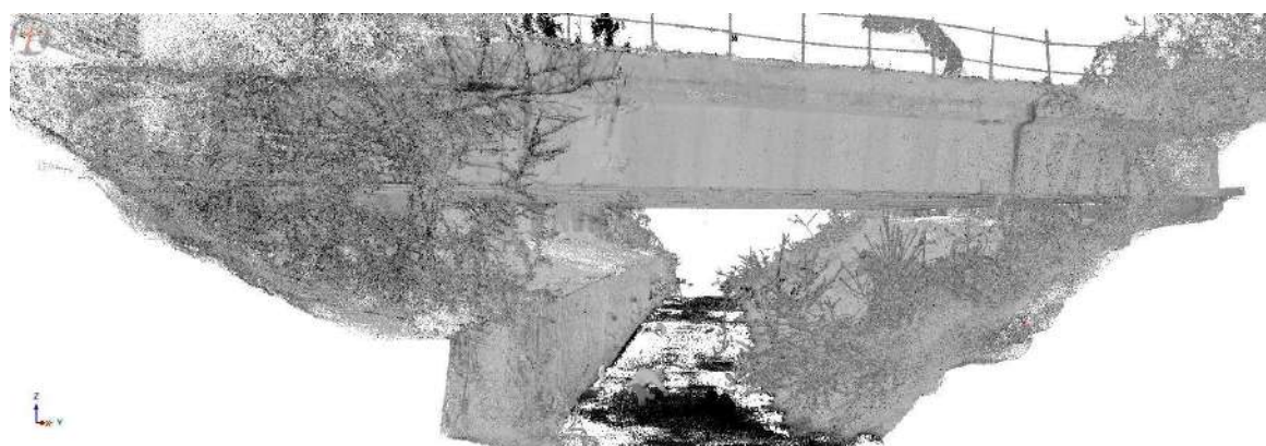
Figura 12 – Nuvola di punti tridimensionali del prospetto est dell'impalcato.
