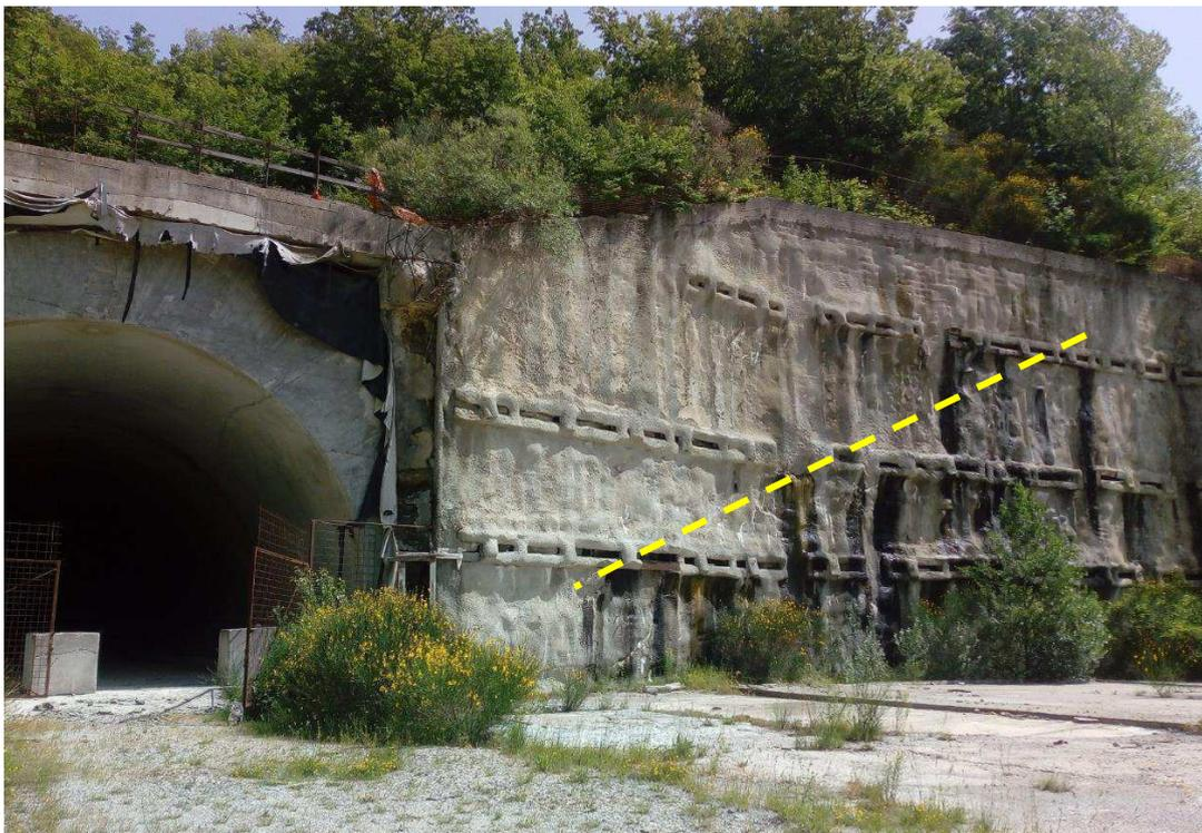
*Fig. 18: Imbocco della galleria Guinza lato-Umbria, con la paratia di micropali tirantati attraverso cui è visibile l'afflusso idrico permanente (o semi-permanente). A meno del "disturbo idrogeologico" ed effetto drenante indotto dagli scavi e dalle fessurazioni secondarie, i punti di afflusso sembrano allineati all'incirca lungo l'immersione (linea gialla tratteggiata, componente lungo la paratia) della stratificazione della Marnoso-Arenacea.*
