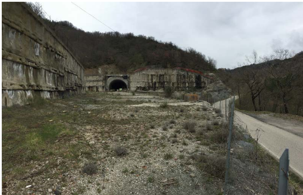
Figure 16. Stato attuale imbocco galleria della Guinza – FOTO 1
