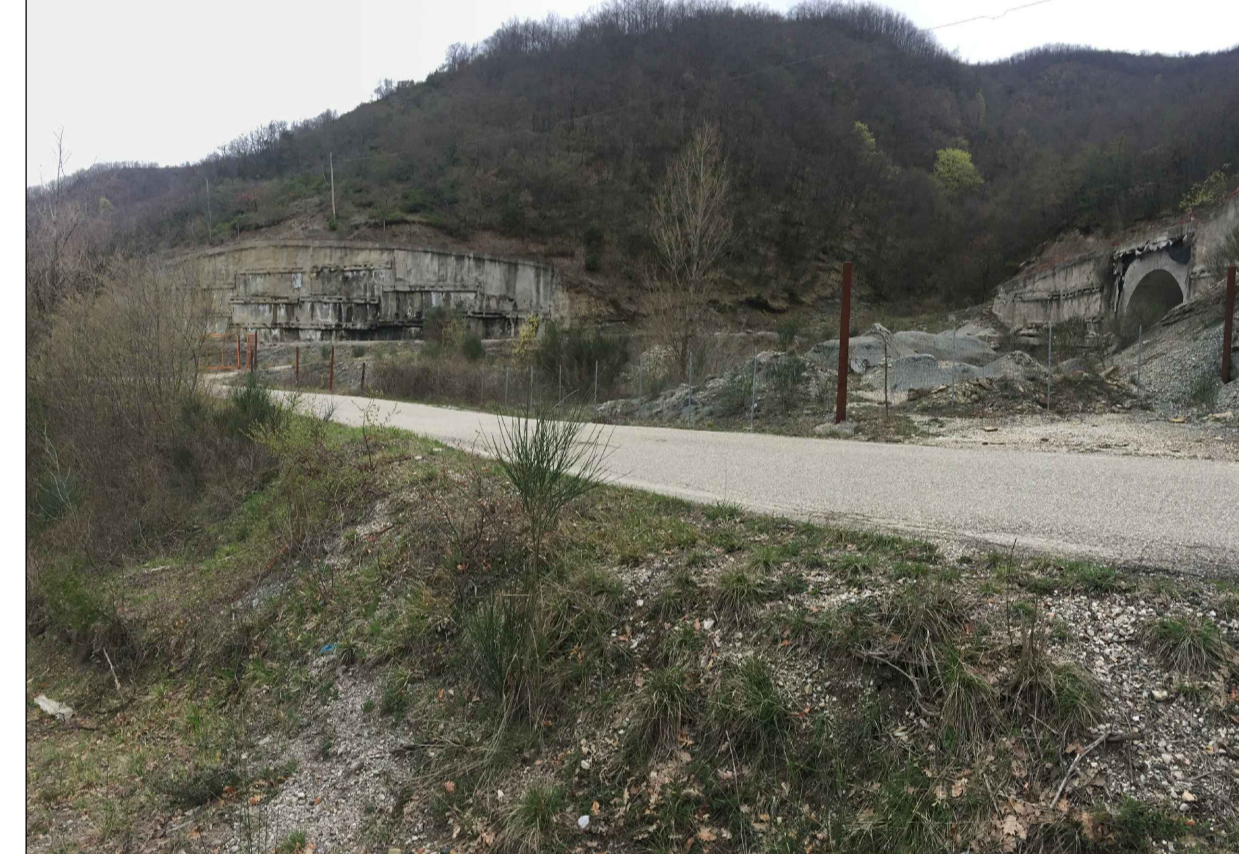
FOTO 3: Vista da nord dell'area di imbocco e dell'area di realizzazione della nuova rotondina
