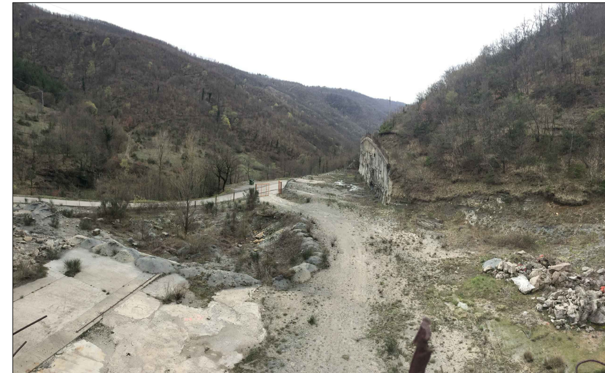
FOTO 5: Vista dall'alto dell'area di realizzazione della nuova rotondina
