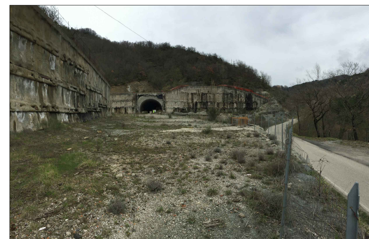
FOTO 1: Vista da sud dell'area di imbocco Galleria Guinza
