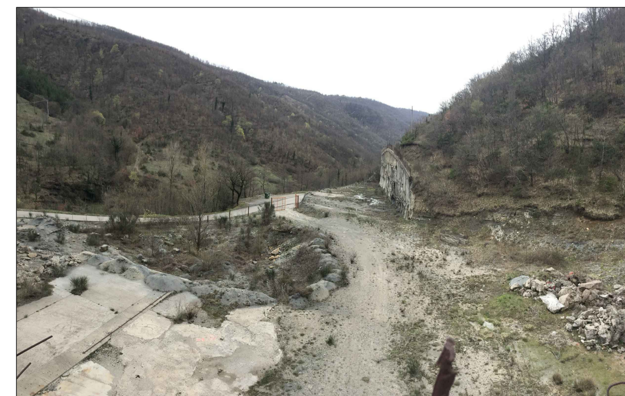
FOTO 5: Vista dall'alto dell'area di realizzazione della nuova rotondella
