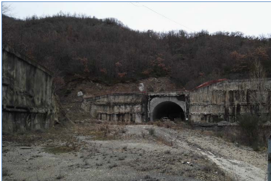
Figure 3. Imbocco galleria della Guinza Umbria
