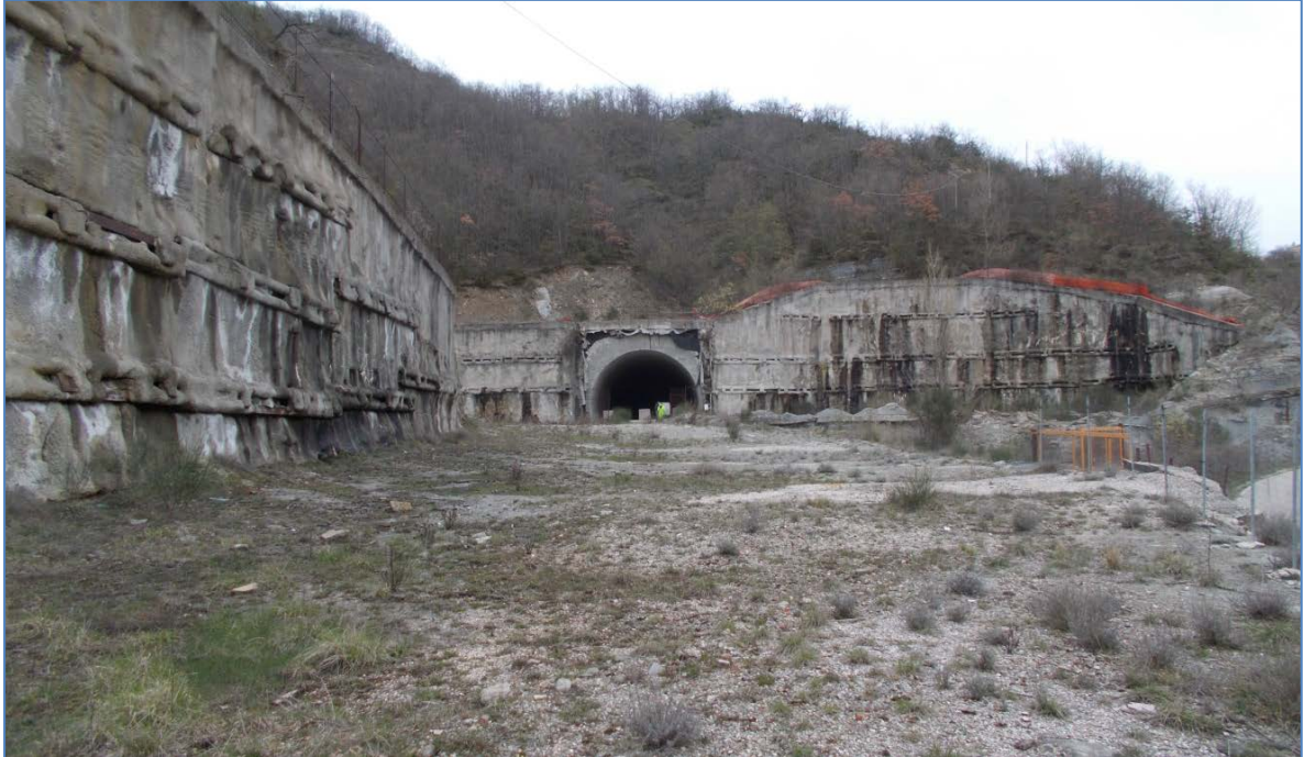
Figure 4. Area cantiere, ingresso galleria e paratie
