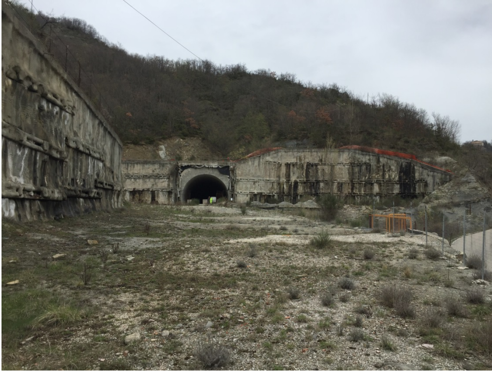
Figura 4 Imbocco della Guinza lato Parnacciano
