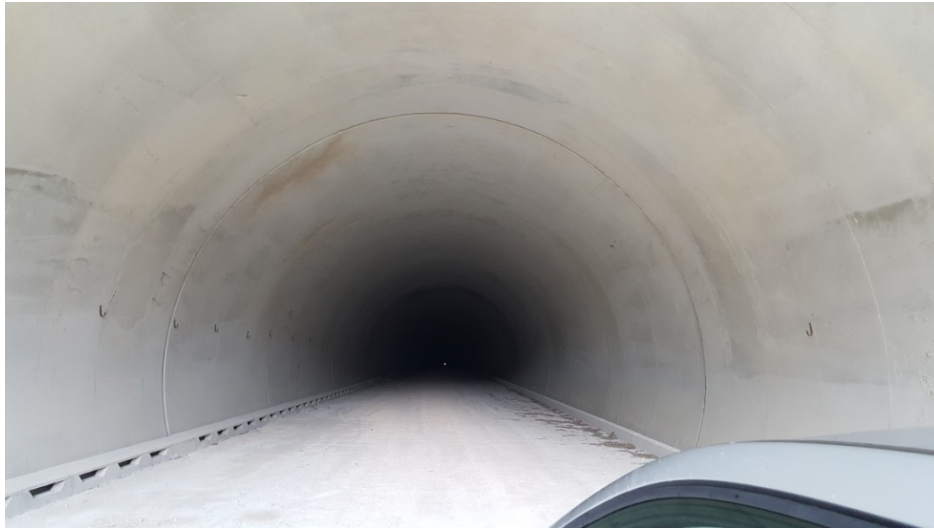
Figura 5 - Interno della Galleria della Guinza
