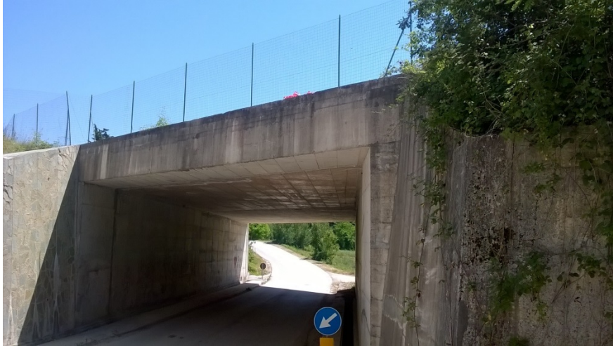
Figura 7 - Sottovia scatolare comunale
