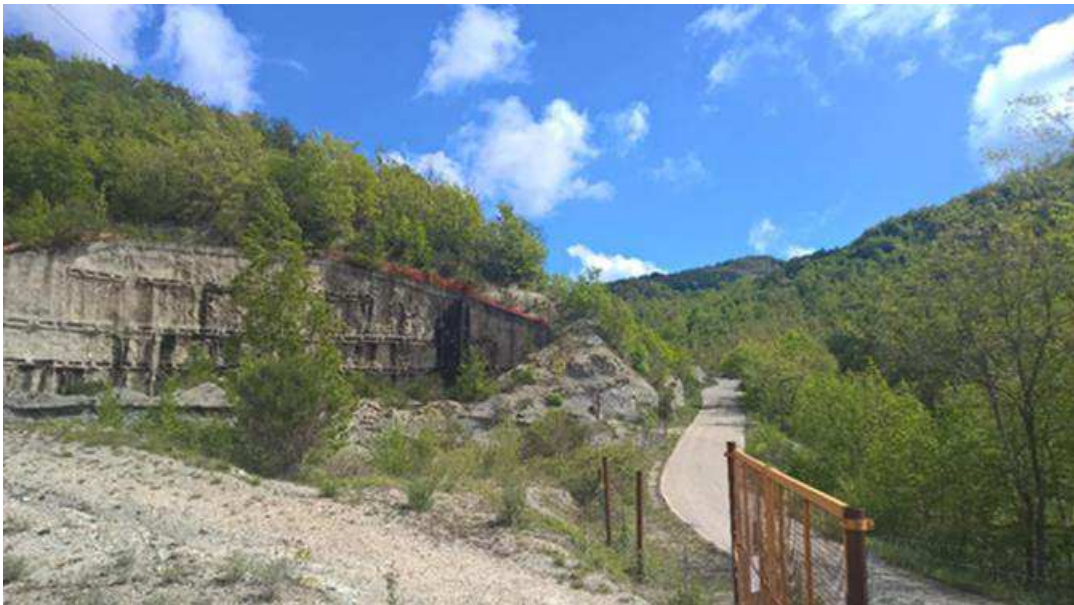
Figura 4 - Viabilità esistente S.P. 200 in prossimità dell'imbocco
