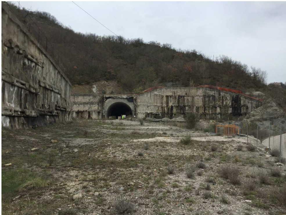
Foto 1 - Imbocco della Guinza lato Parnacciano
