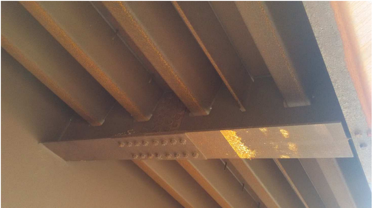
Figura 26 - cordolo del viadotto metallico
