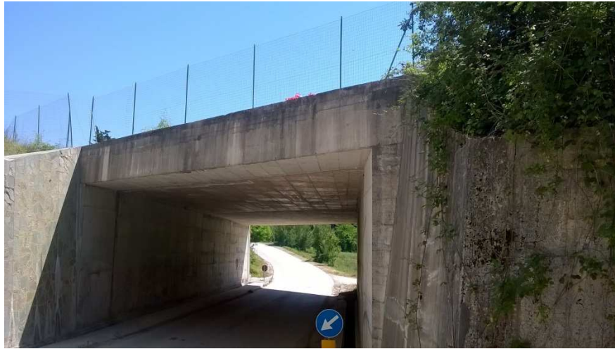
Foto 4 - Sottovia scatolare comunale
