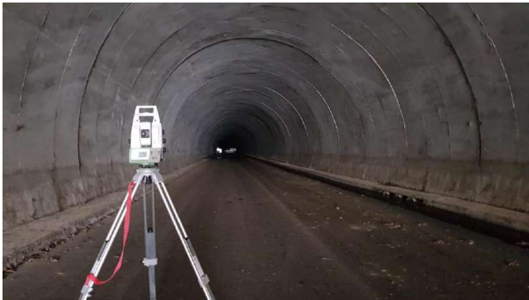
Figura 8 –Stazione totale Leica TS60 durante il rilievo della galleria Sant'Antonio seconda canna.
