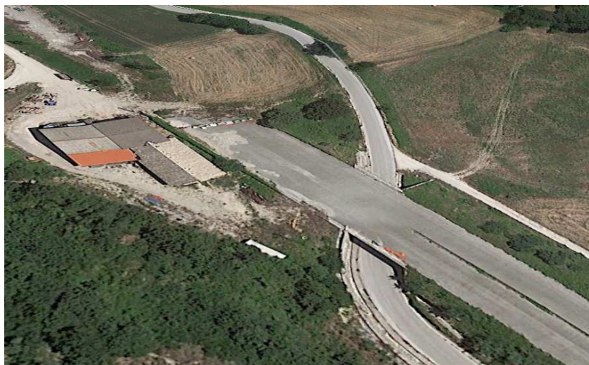
Figura 28 - termine dell'intervento lato Mercatello s. M.
