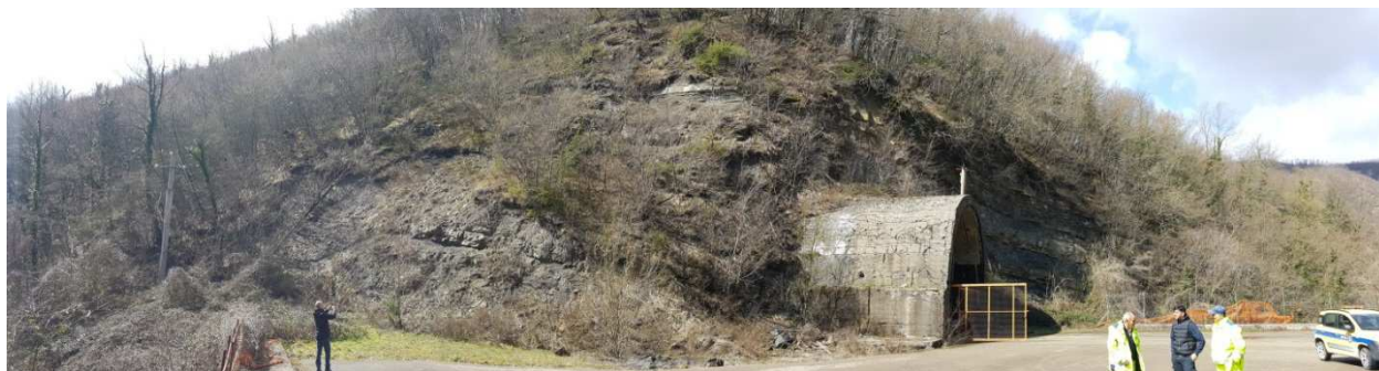
Foto 9 - Imbocco galleria Guinza lato Mercatello sul Metauro (PU)
