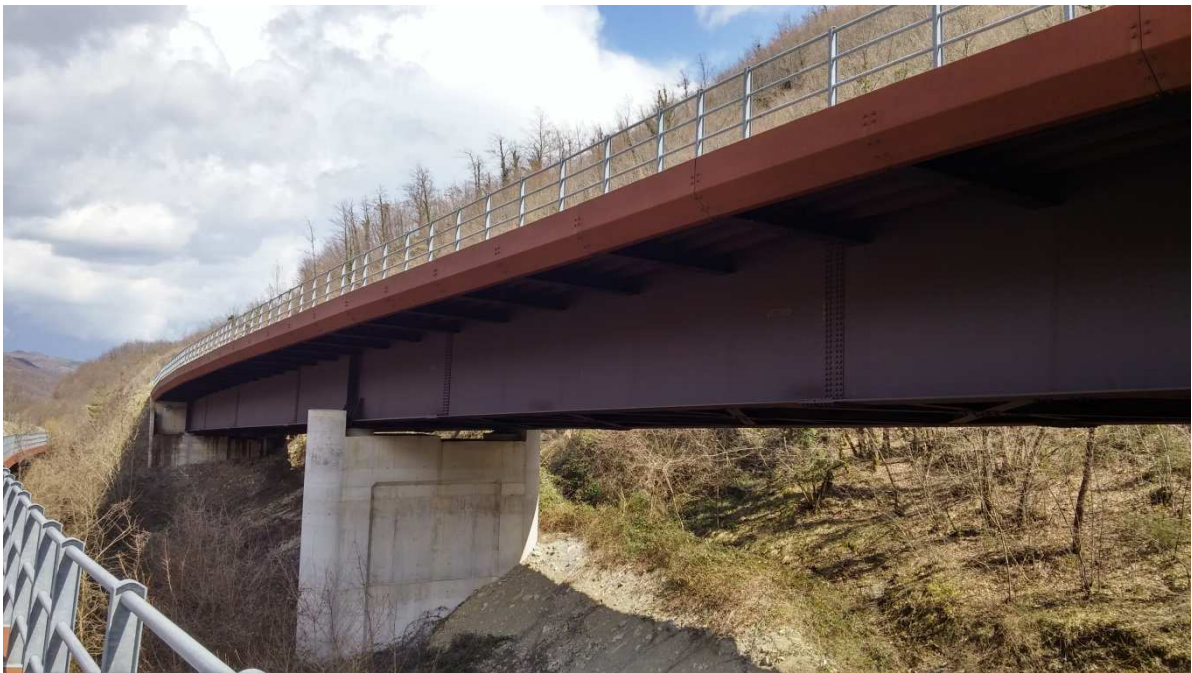
Figura 18 - impalcati sfalsati costituenti il Viadotto Sorgente
