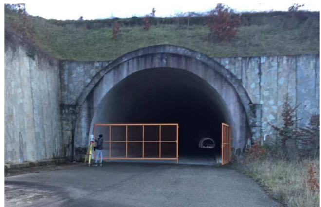
Foto 18 – Galleria Valpiana - imbocco nord lato Marche
