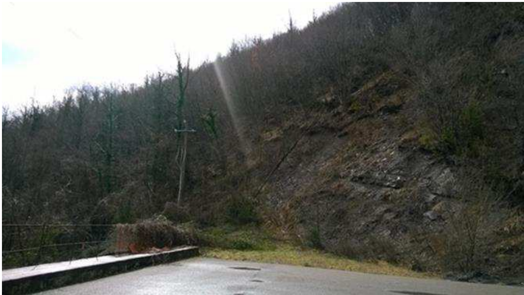
Foto 16 – Ponte- Dettaglio cordolo
