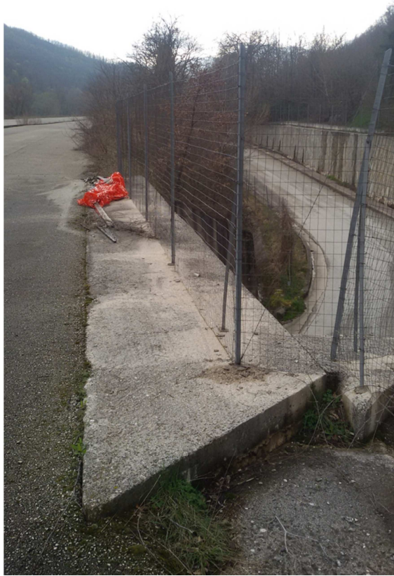
Foto 33 – Particolare cordolo sottovia scatolare
