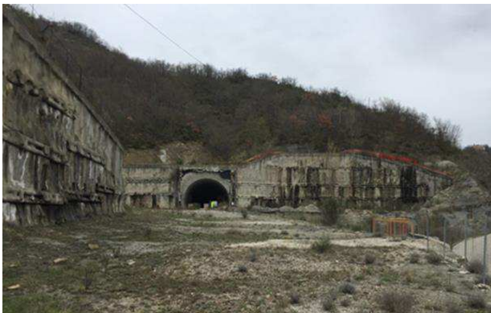
Foto 8 – Area di imbocco Galleria Guinza lato Umbria
