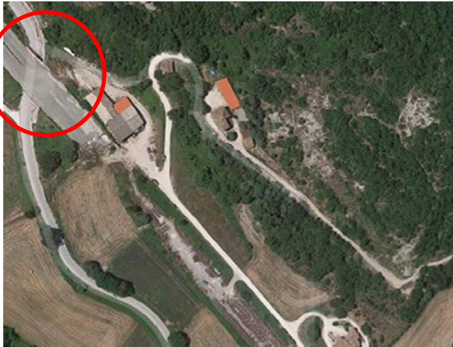
Foto 30 - Sottovia scatolare comunale
