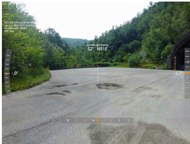
Foto 11 – Area di imbocco galleria Guinza lato Marche
