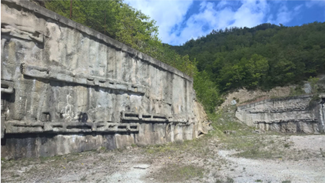
Foto 6 – Paratie laterali ubicate nell'area di imbocco
