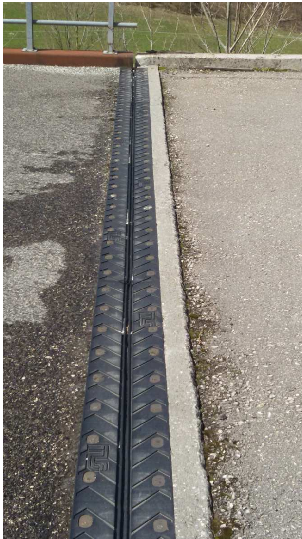
Foto 23 – Dettaglio giunto viadotto sorgente
