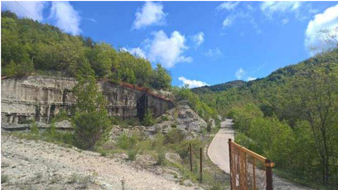
Foto 7 – Viabilità esistente S.P. 200 in prossimità dell'imbocco
