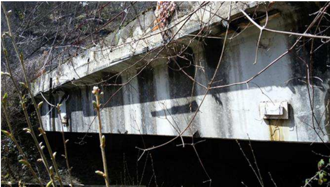
Foto 14 – Ponte – Dettaglio trave di bordo
