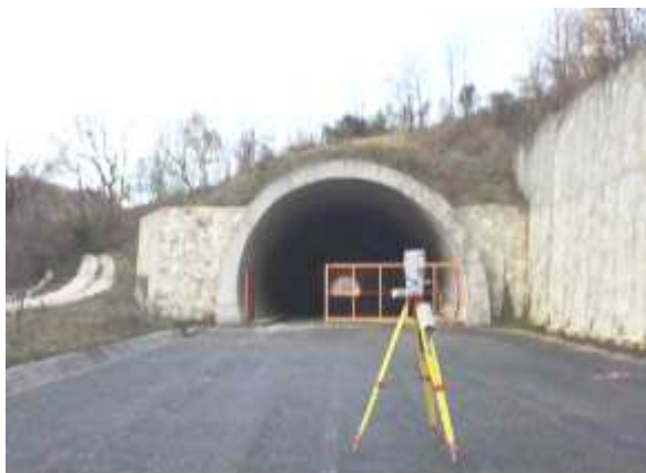
Foto 17 – Galleria Valpiana - imbocco sud lato Umbria
