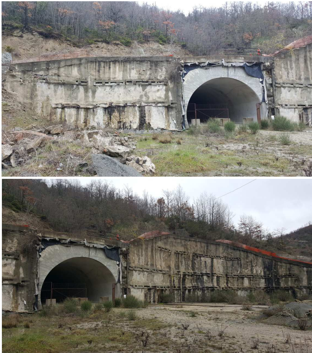
Figura 30 - paratia tipo berlinese all'imbocco sud della galleria Guinza
