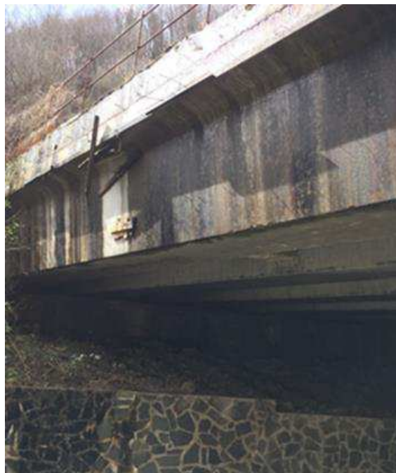
Foto 15 – Ponte – Dettaglio trave di bordo
