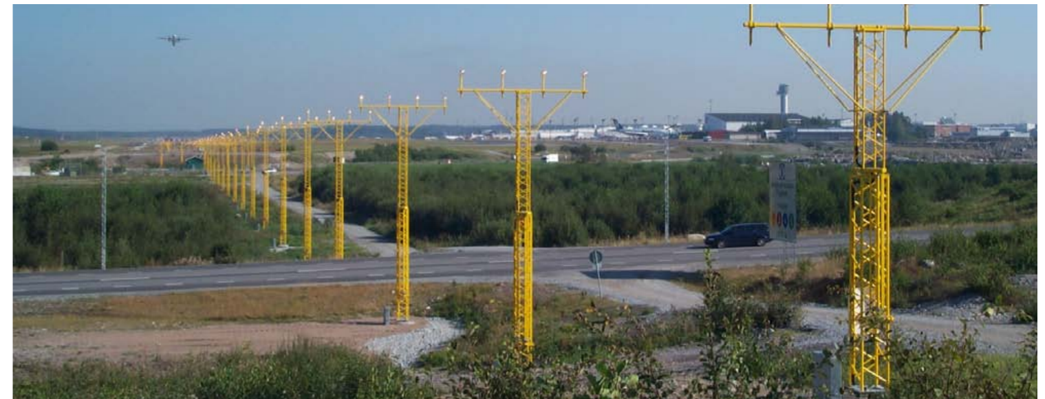
Esempio di sentiero luminoso di avvicinamento su pali frangibili
