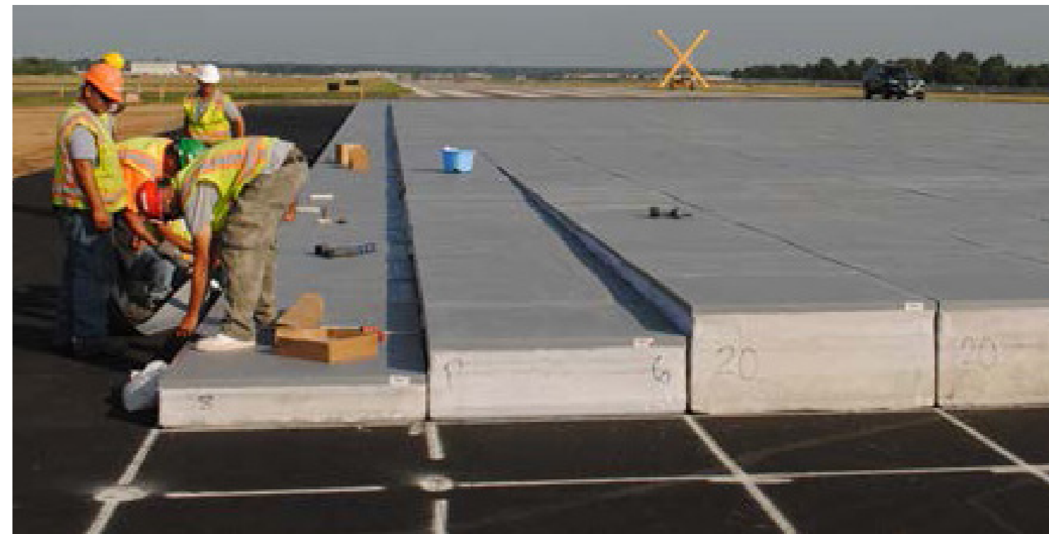
Esempio di posa del letto di arresto
