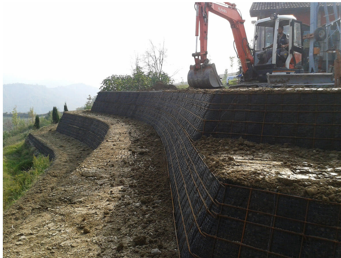
Cantierizzazione gradonate per lo stoccaggio delle terre
