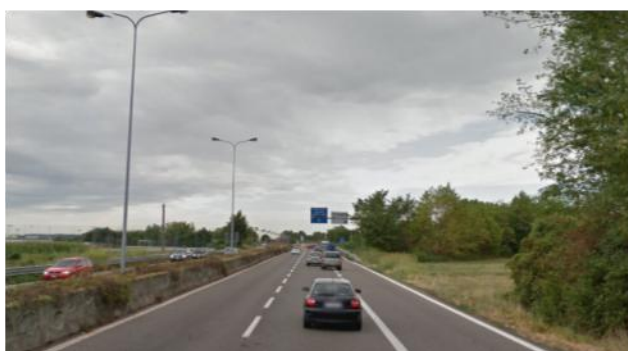
Tra svincolo A.I. SS671 e aeroporto Direzione aeroporto
