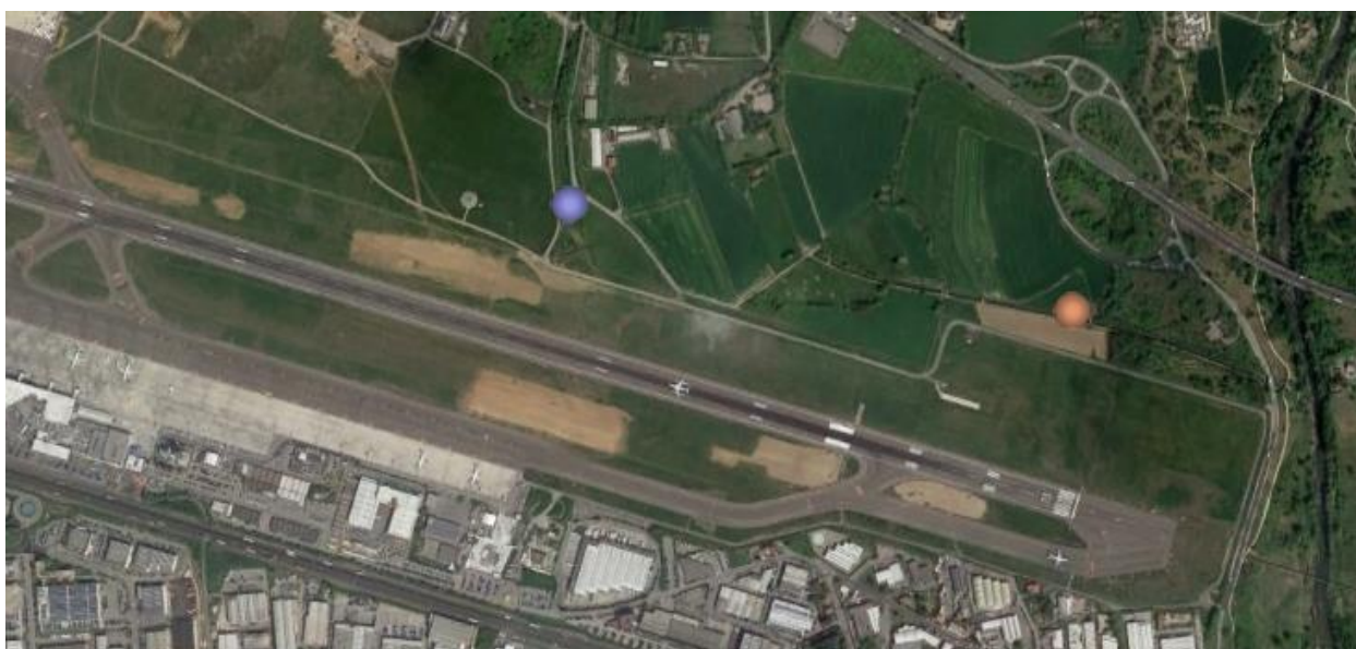
Figura 12-1 Localizzazione delle aree di cantiere (in viola: cantiere logistico; in arancione: area di deposito temporaneo)
