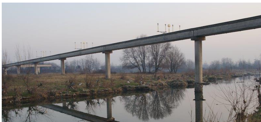
Figura 14-5 Sentiero luminoso in testa pista 10: stato attuale
