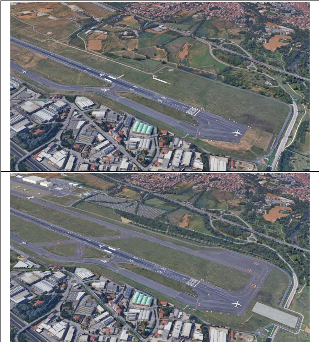
Figura 12-4 Fotosimulazione confronto ante e post operam: interventi infrastrutturali, la nuova fascia boscata e le formazioni arboree-arbustive lungo il margine aeroportuale orientale
