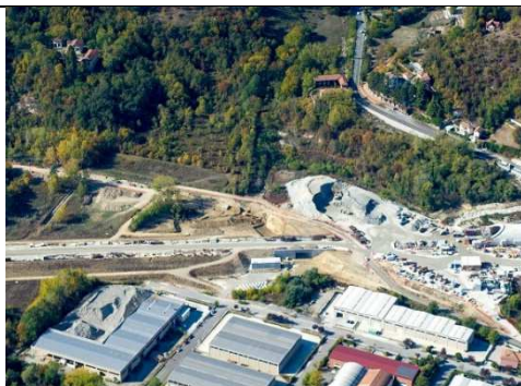
Figura 1 Rifacimento strada di accesso ai cantieri COP4 e COP5 in Arquata Scrivia (fig 1)
