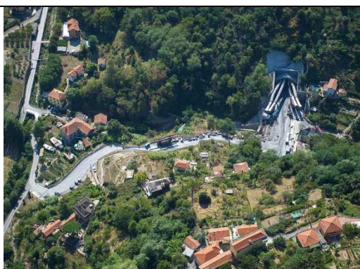
Figura 3 Punto di vista 1 NVV0501 L Nuova viabilità di accesso al cantiere Fegino Imbocco Sud Galleria di Valico
