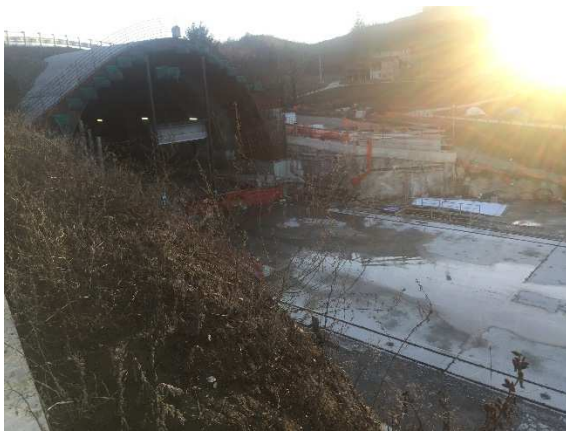
Figura 5 Cantiere Moriassi (Gall Naturale Valico Nord)
