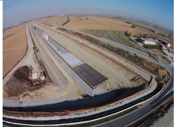
Figura 2 Galleria artificiale a Pozzolo (fig 2)
