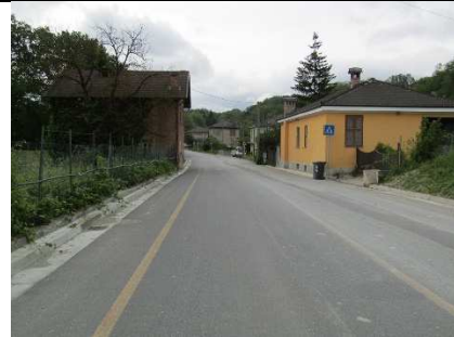
Figura 6 Cantiere Moriassi e Radimero Viabilità terminata (fig 1 SUD)
