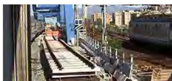
Uno dei cantieri per il nodo ferroviario
