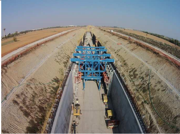
Figura 1: Galleria artificiale a Pozzolo (Fig 1)
