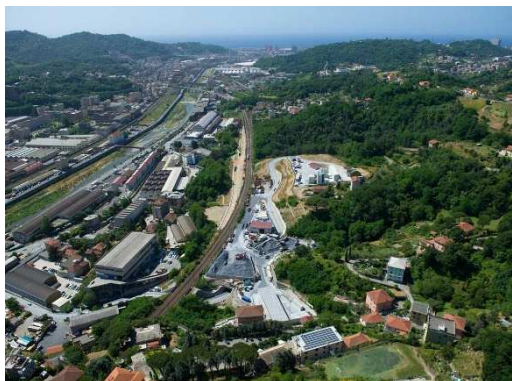
Figura 1-- Punto di vista 1 NVVA01 L
