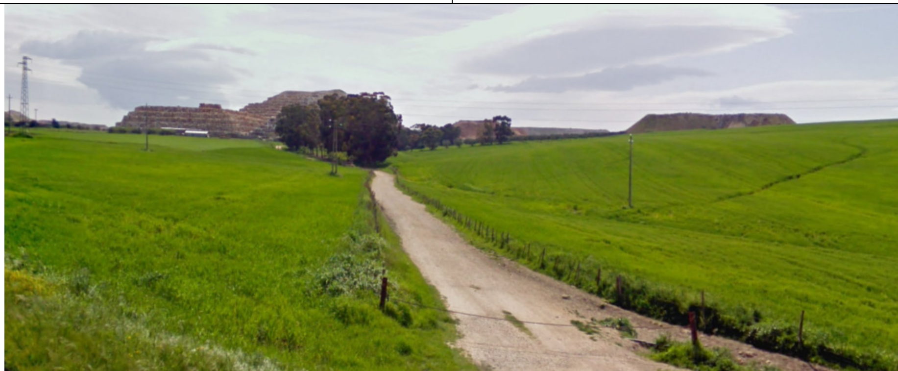
Foto 1: Dalla SP39 ingresso della masseria - INACCESSIBILE
