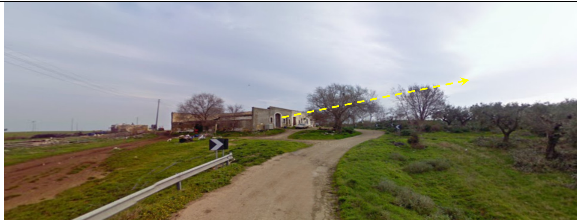
Foto 2: dalla SP39. L'impianto eolico proposto è a dx dell'osservatore, nascosto dalle alberature stradali.
