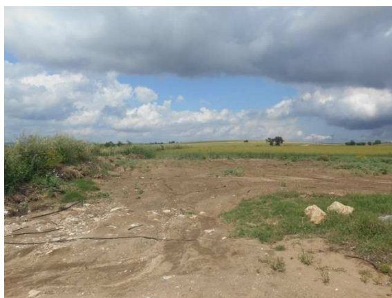
43. Cavidotto lungo la SP 36, località Scardazzo
