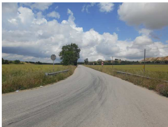
37. Cavidotto da SP 36 in direzione della SP 33, località Cioccherelle
