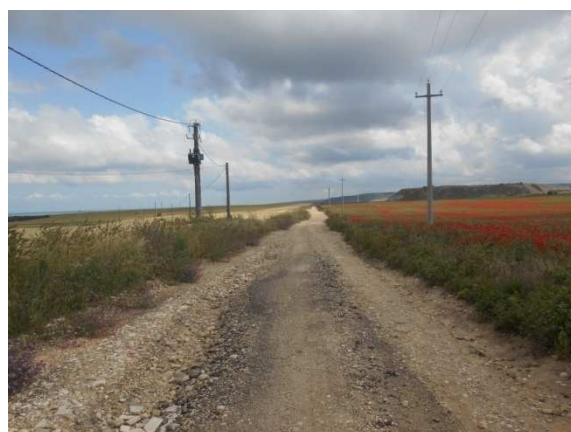
25. Cavidotto tra le turbine 1 e 2, località Giardina
