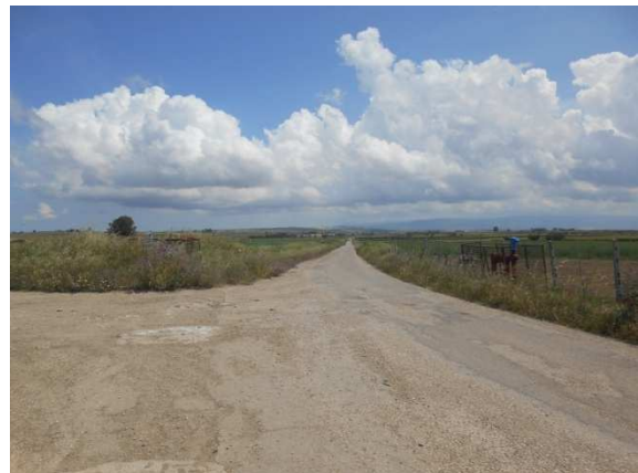
51. Cavidotto da strada vicinale Titolone a strada vicinale Serracannola Apricana
