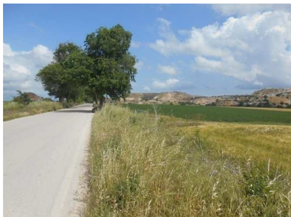
34. Cavidotto lungo la SP 33
