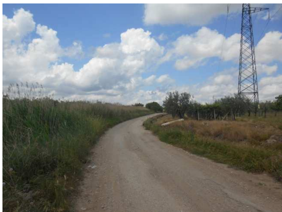
55. Cavidotto lungo la SP 31, località Quarantotto
