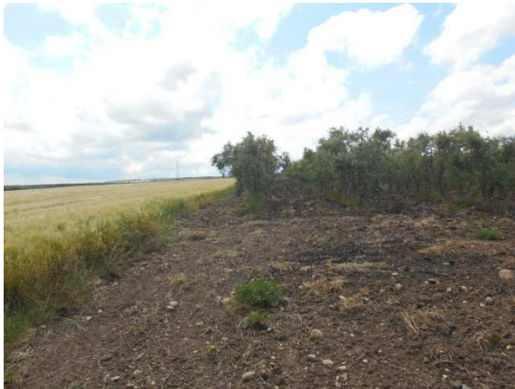
67. Cavidotto in direzione delle stazione elettrica ed area UT 4, località C. M. S. S. d'Altomare
