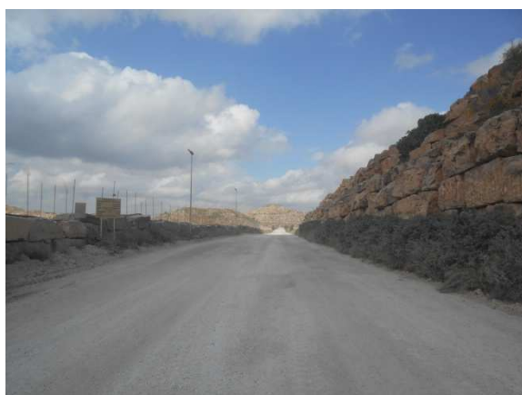
28. Cavidotto lungo la SP 37 (interno cava)
