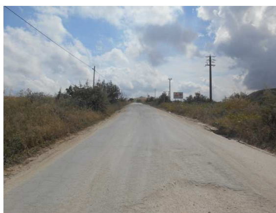
29. Cavidotto lungo la SP 37 (interno cava)
