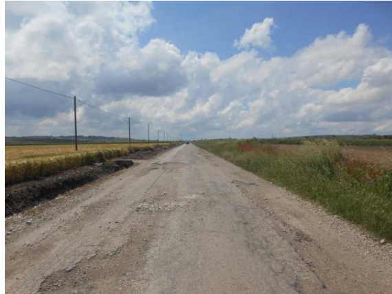
52. Cavidotto lungo la strada vicinale Titolone, località Quarantotto
