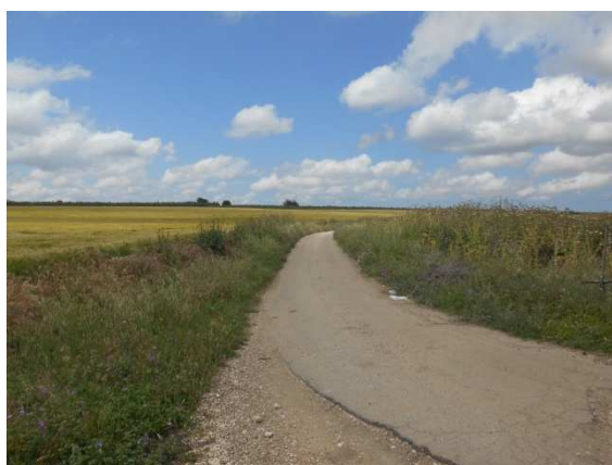
66. Cavidotto in direzione della stazione elettrica, località C. M. a S. S. d'Altomare
