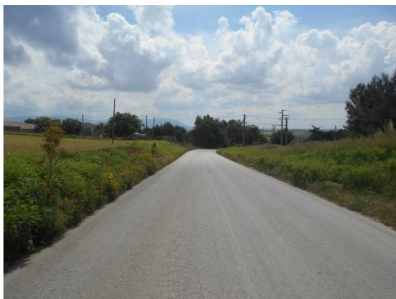
35. Cavidotto lungo la SP 33
