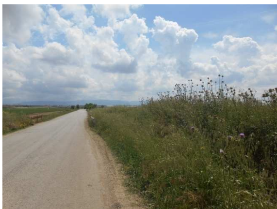
44. Cavidotto lungo la SP 36, località Scardazzo
