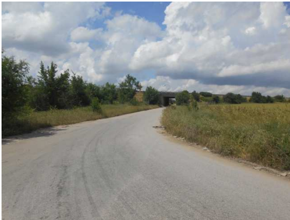
38. Cavidotto lungo la SP 36, località Cioccherelle
