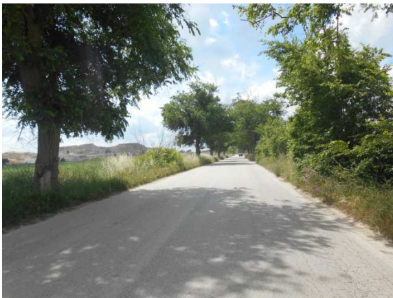
32. Cavidotto lungo la SP 33
