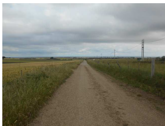
10. Cavidotto interno da in direzione della turbina 7, località Cimaglia
