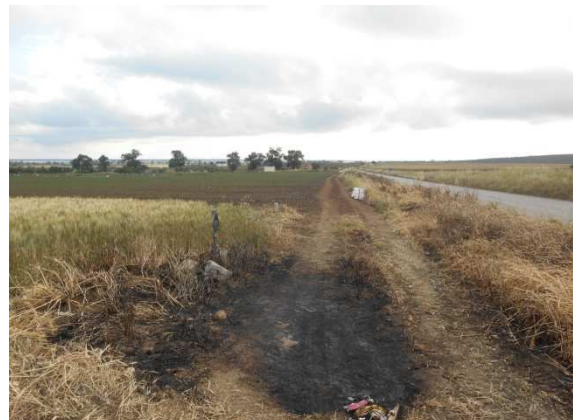
4. Cavidotto lungo la SP 38, località Campo di Pietre/Sgrascina
