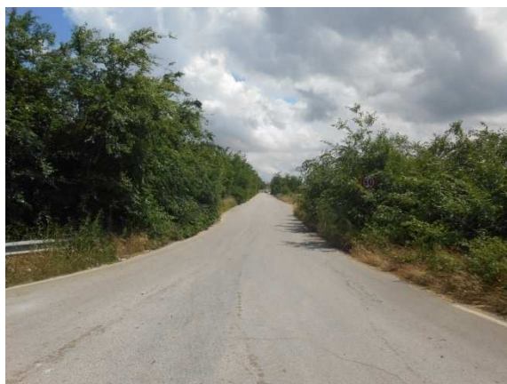
46. Cavidotto da SS 16 in direzione della SP 36
