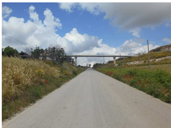
36. Cavidotto lungo la SP 33
