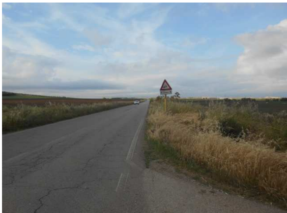
3. Cavidotto lungo la SP 38, località Campo di Pietre/Sgrascina
