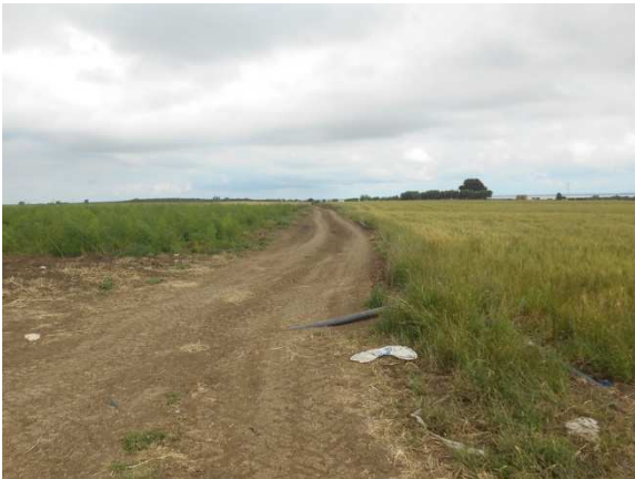
13. Cavidotto interno tra le turbine 6 e 7, località Cimaglia
