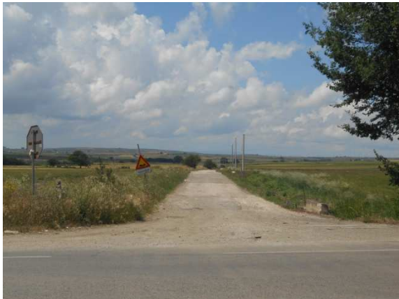
47. Cavidotto da SS 16 in direzione della strada vicinale Serracannola Apricana
