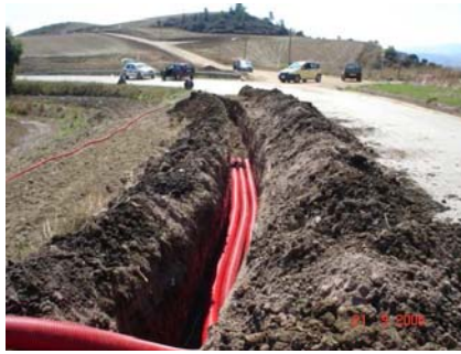
Fig. 1.4 - Foto illustrativa della messa in posa dei cavidotti MT
