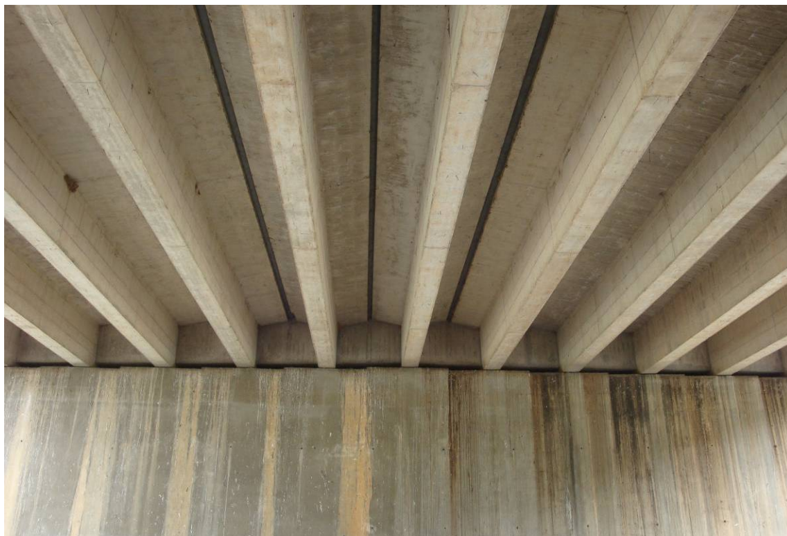
Foto 3 – Vista intradosso impalcato e muro frontale spalla
