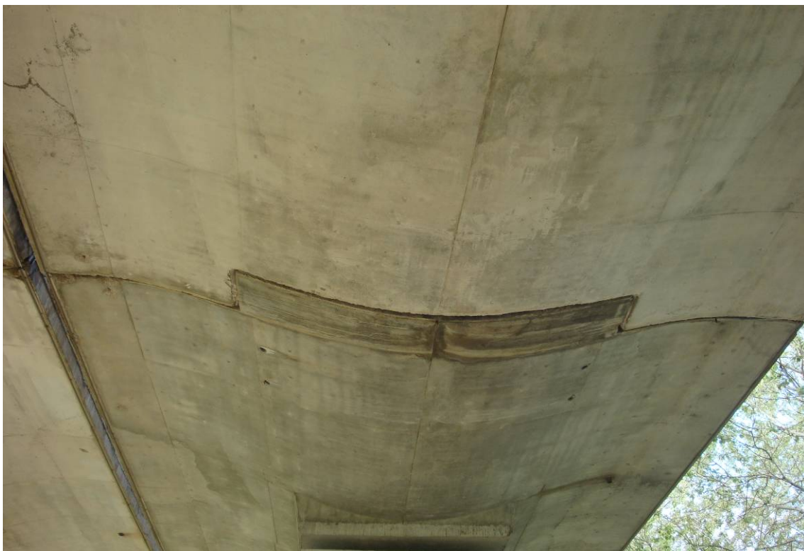
Foto 17 – Particolare particolare della seggiola Gerber
