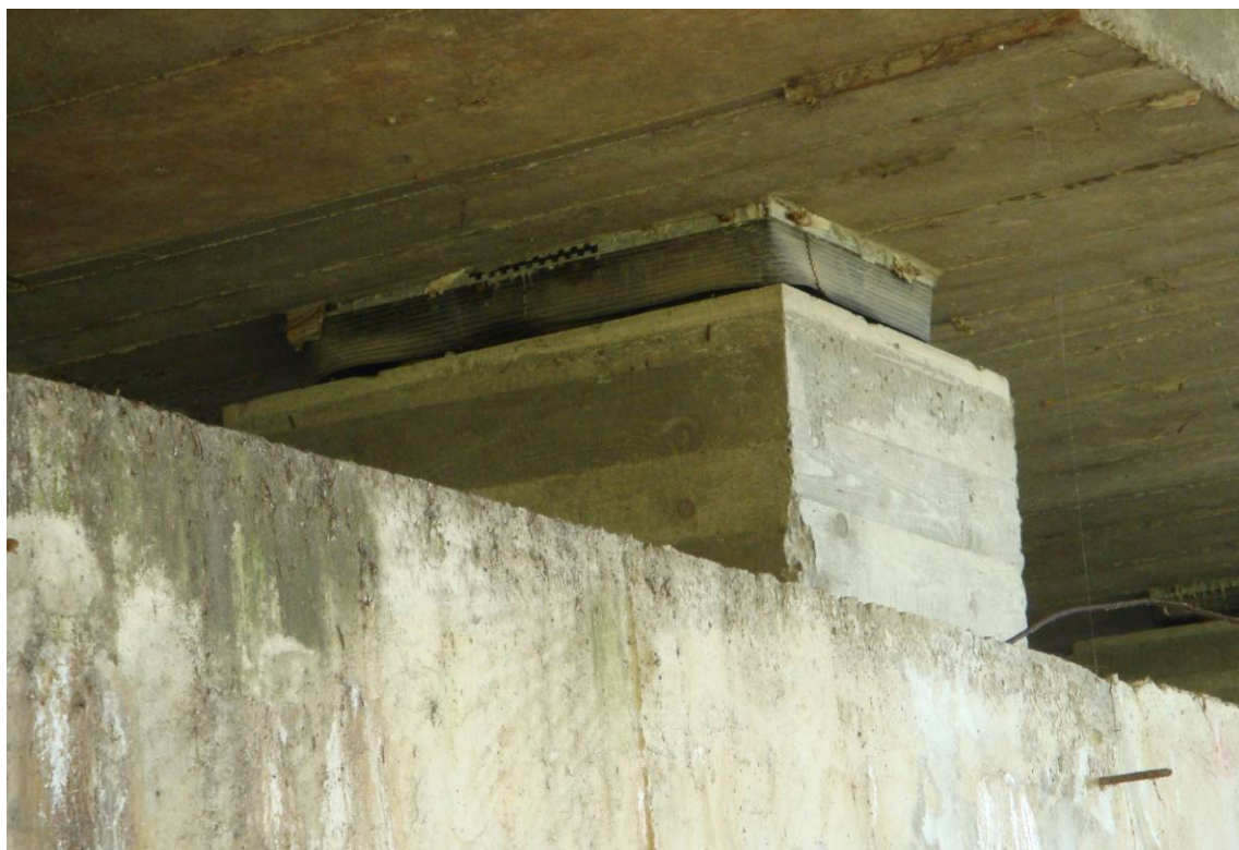
Foto 14 – Particolare dell'appoggio sulla spalla lato Roma
