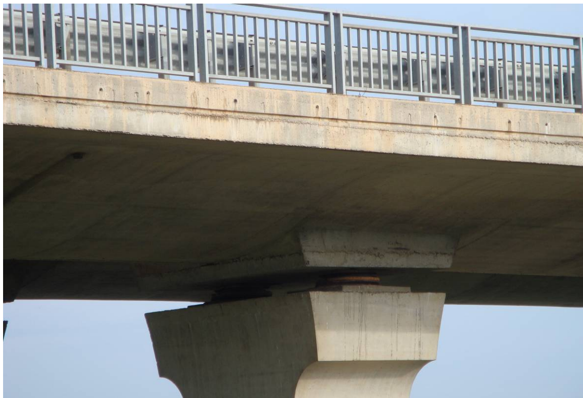
Foto 13 – Particolare del pulvino e del traversone di appoggio dell'impalcato
