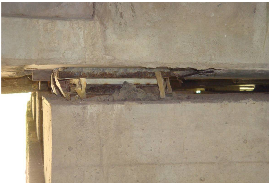
Foto 7– Particolare appoggio
