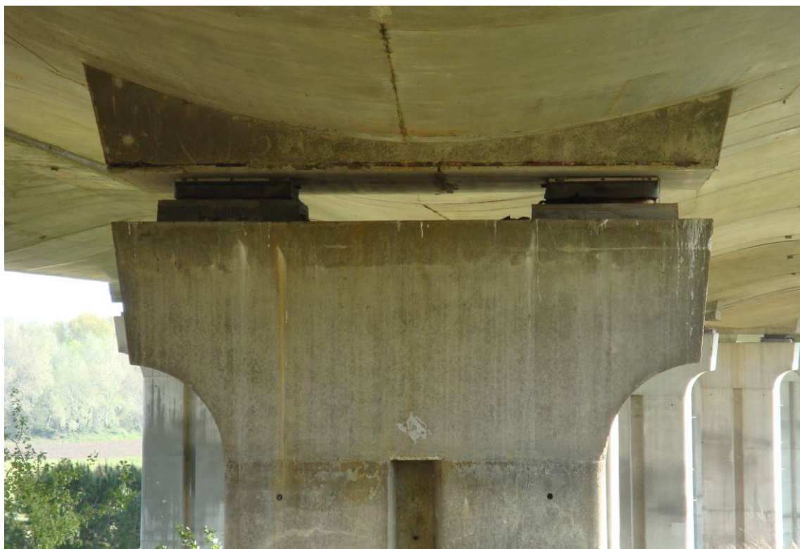
Foto 12 – Particolare del pulvino e del traversone di appoggio dell'impalcato
