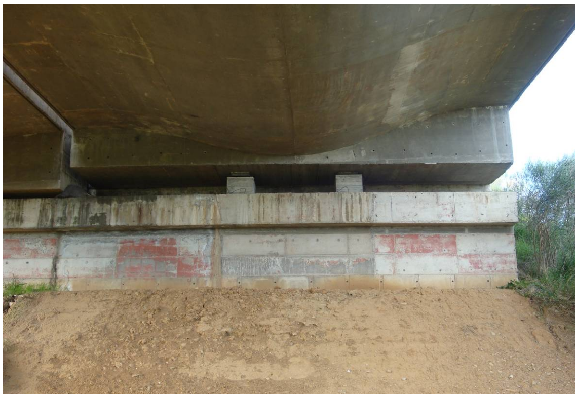
Foto 10 – Vista intradosso – particolare della spalla lato Roma
