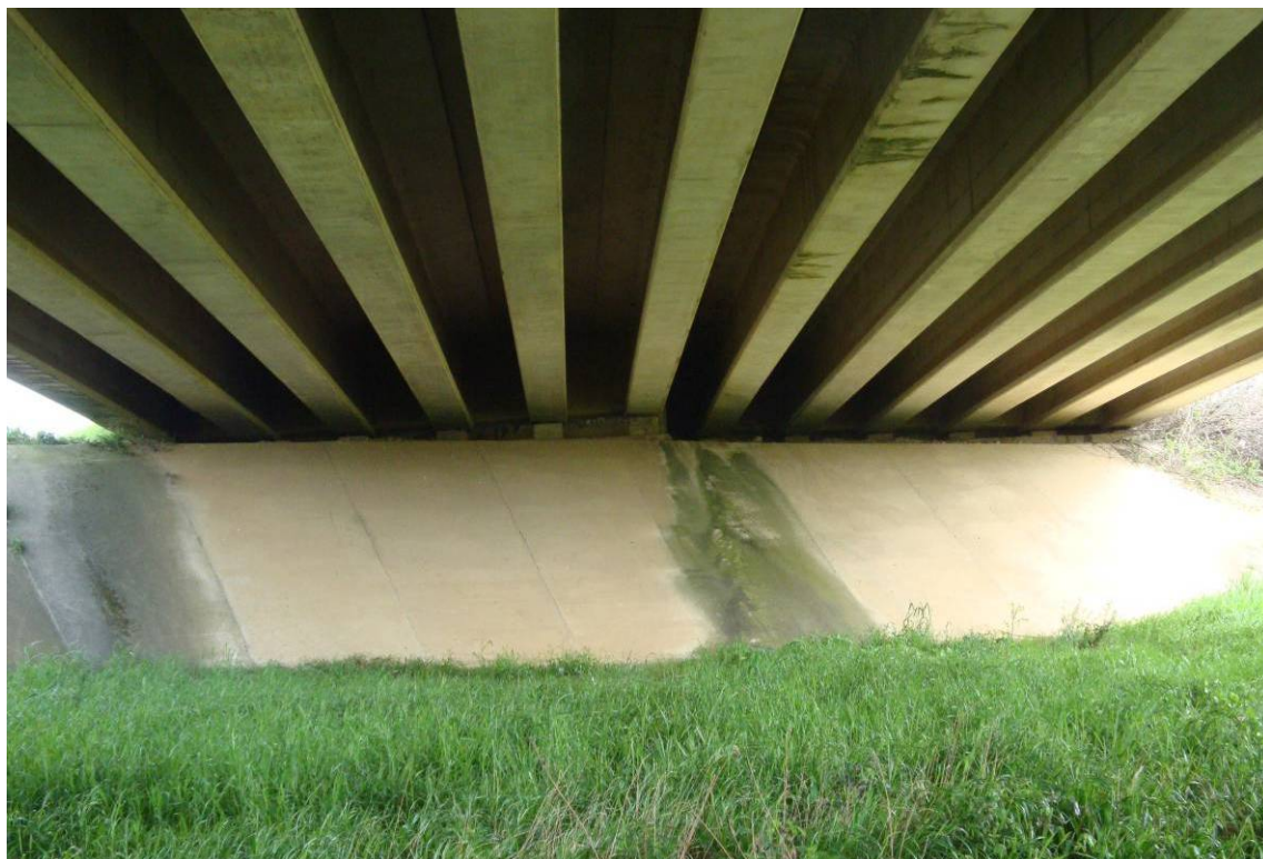
Foto 5 – Vista intradosso – particolare argine rivestito in c.a.
