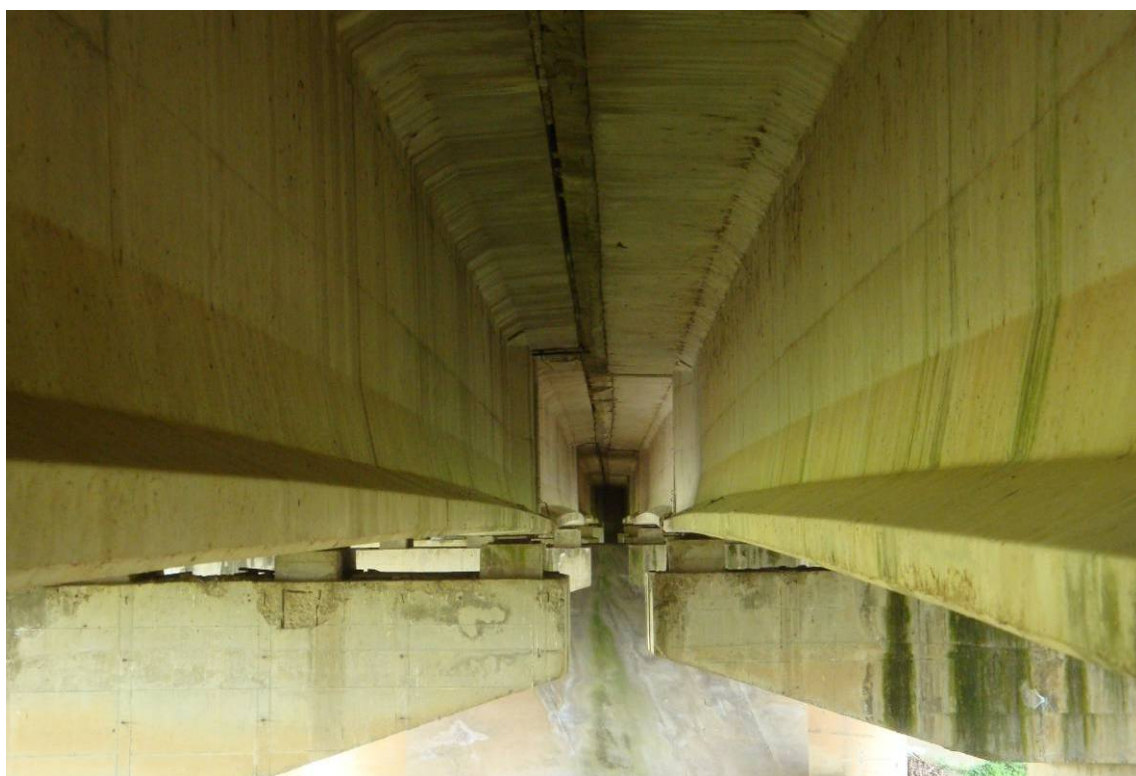
Foto 8 – Particolare giunto tra i 2 impalcato
