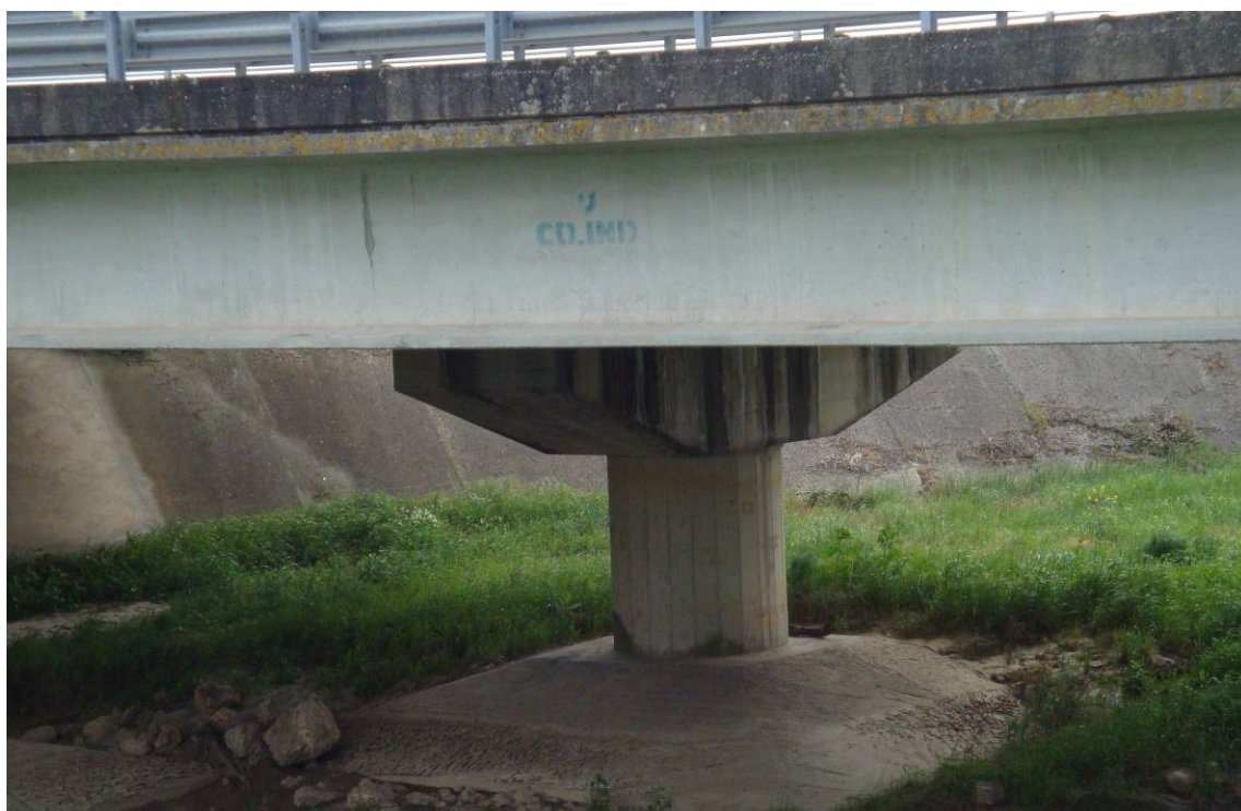
Foto 12 – Zattera di fondazione della pila – Particolare marchio COIND sulla trave
