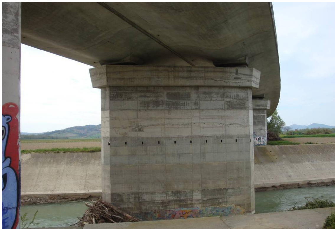
Foto 9 – Vista intradosso e pile a setto nell'alveo del fiume Ombrone
