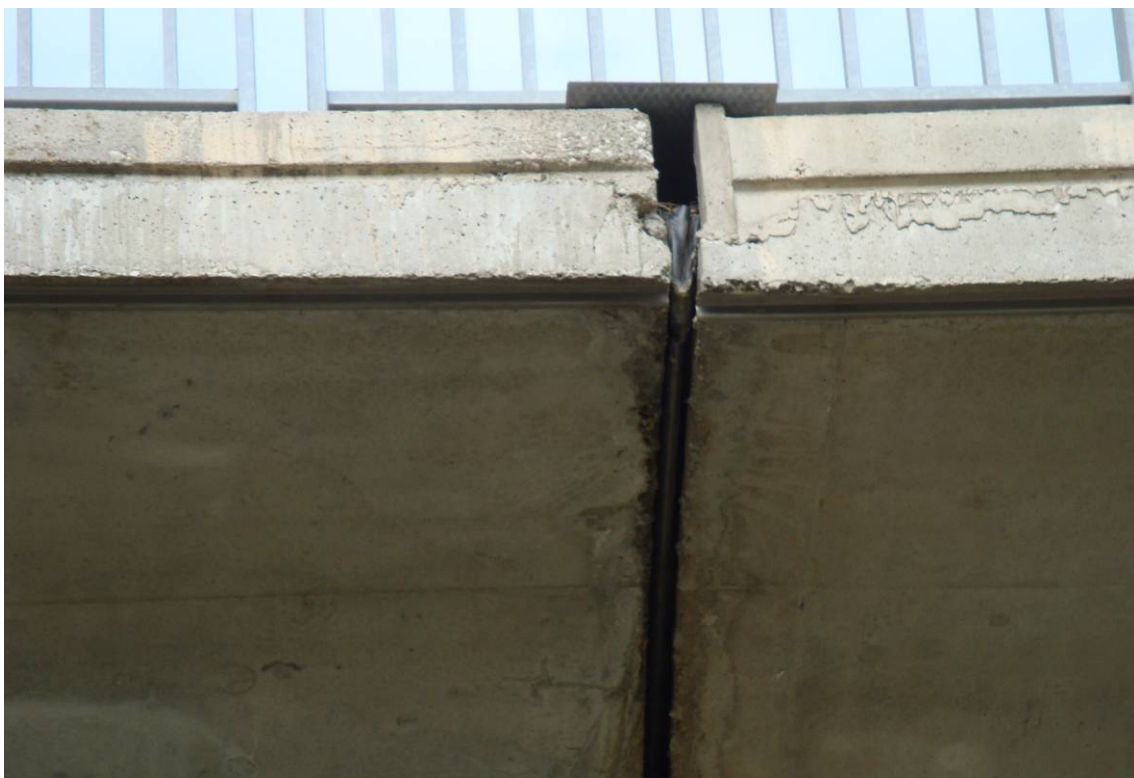
Foto 18 – Particolare della seggiola Gerber
