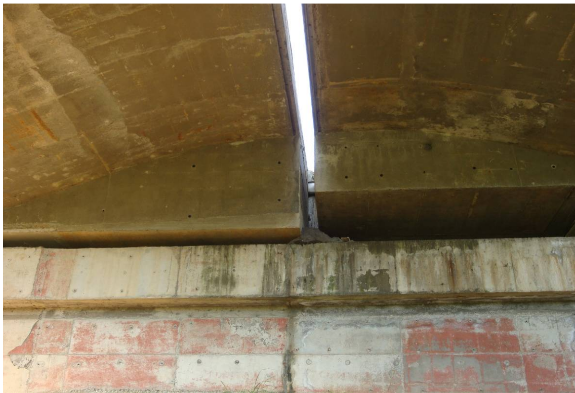
Foto 11 – Vista intradosso – particolare della spalla lato Roma
