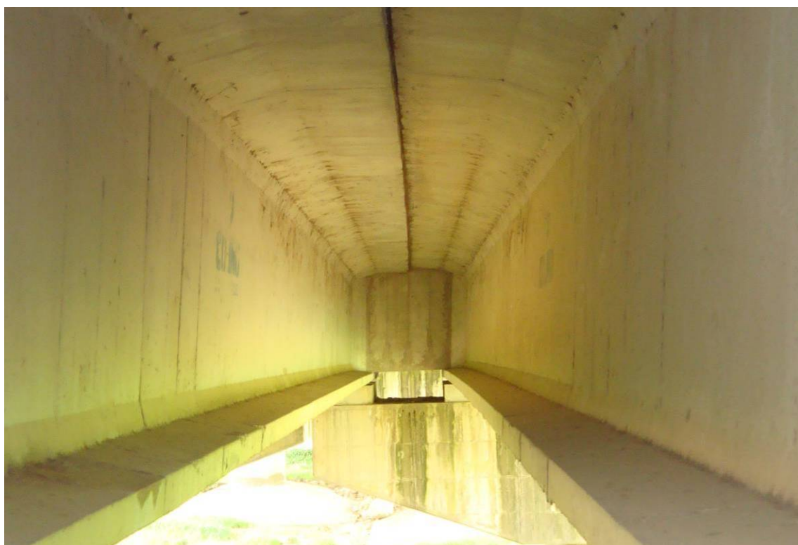
Foto 8 – Particolare giunto longitudinale tra le ali delle travi
