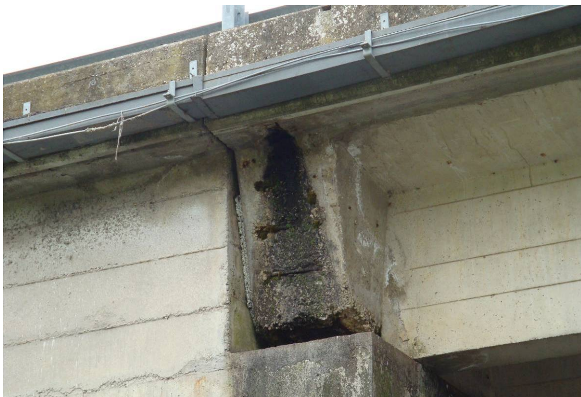
Foto 6 – Cls. umido e dilavato sui traversi
