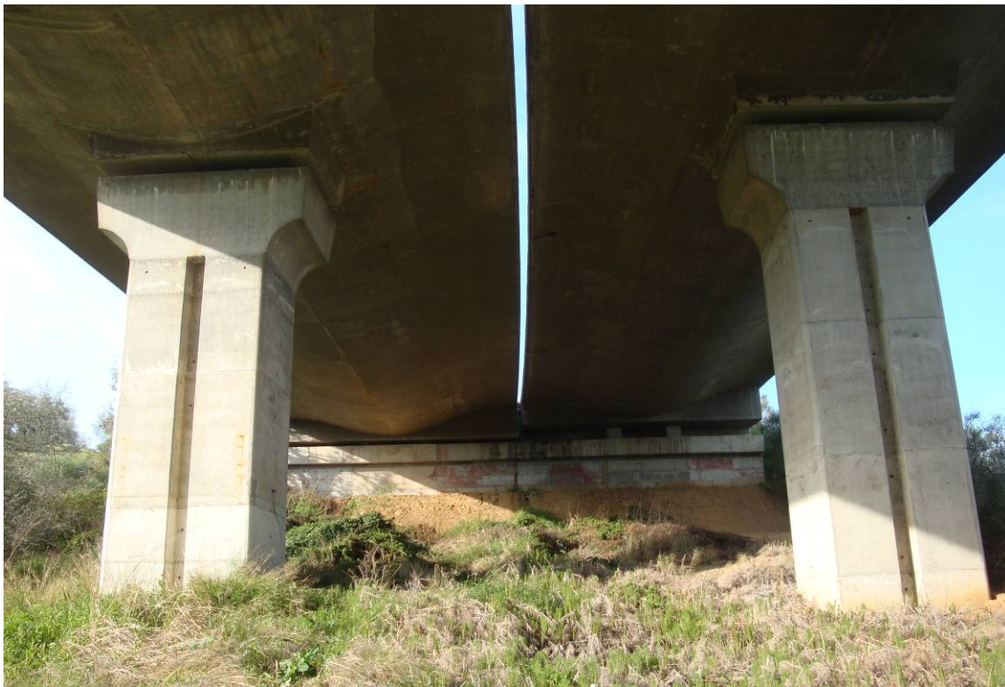
Foto 5 – Vista intradosso e spalla lato Roma
