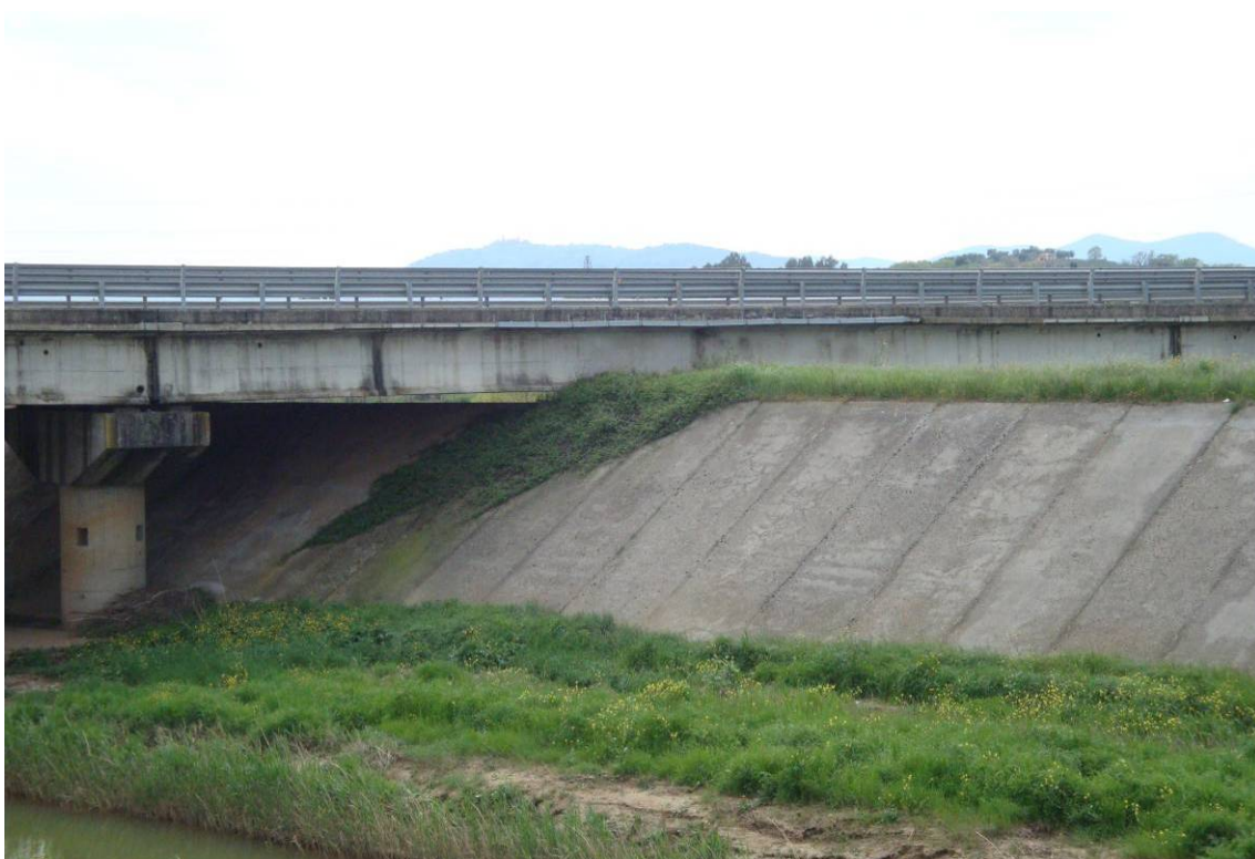
Foto 12 – Vista argine rivestito in cls.
