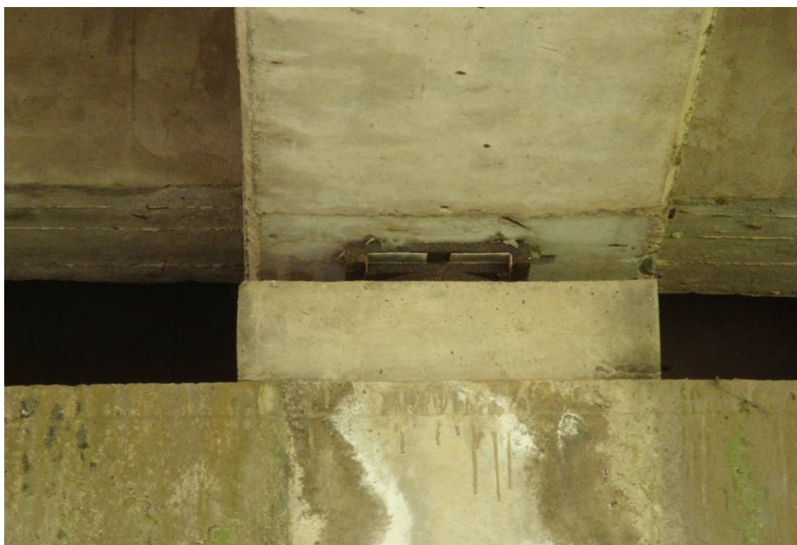
Foto 6 – Particolare appoggio delle travi
