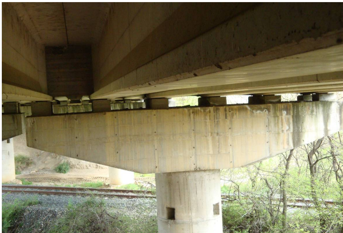
Foto 7– Particolare degli appoggi
