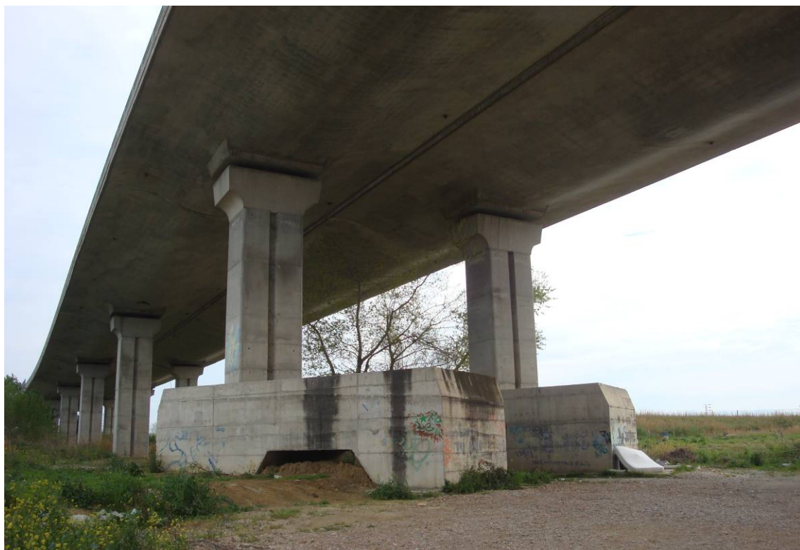
Foto 8 – Vista intradosso – zattere di fondazione delle pile in prossimità del lato destro del fiume Ombrone
