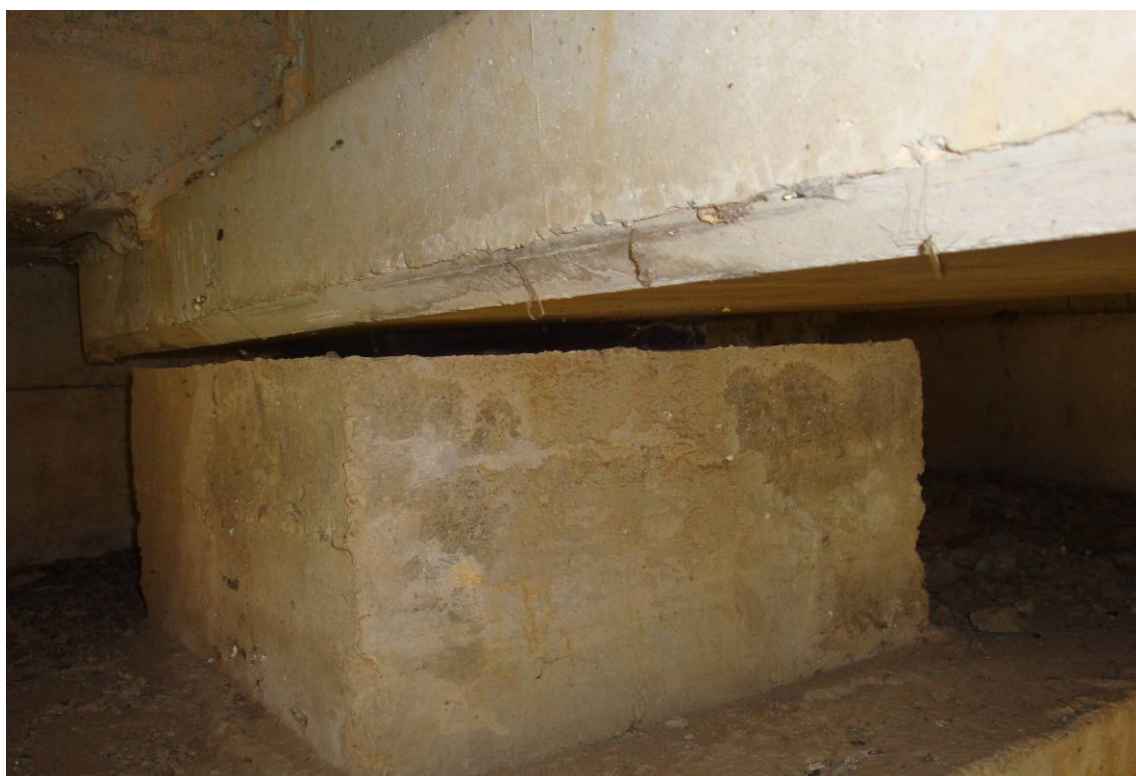
Foto 8 – Particolare dell'appoggio sulla spalla
