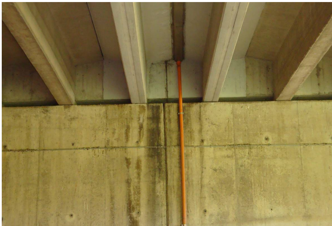
Foto 7– Appoggio delle travi sulle spalle
