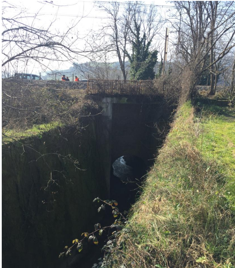
Figura 11: Attraversamento ferroviario esistente sul Vallone del Fangara.
