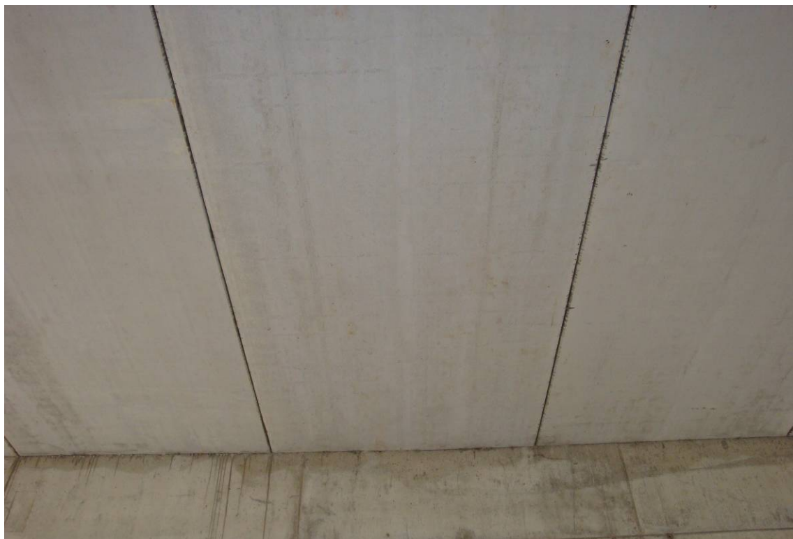
Foto 4 – Vista intradosso – particolare predalles
