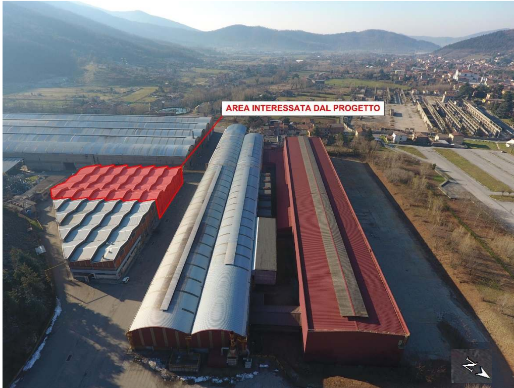
Scatto NORD-EST da Drone con Area interessata dal Progetto
