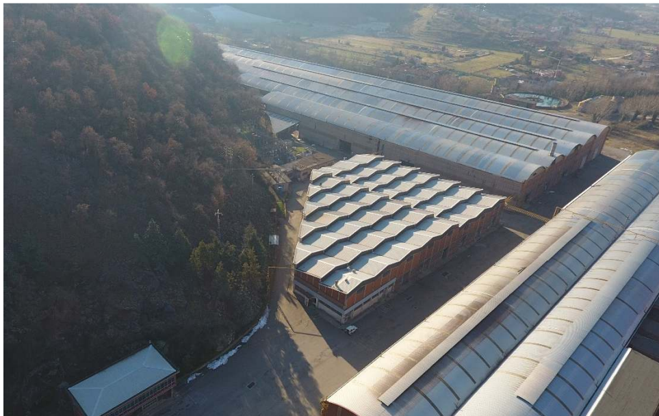
Fig. 7 L'edificio individuato per collocare l'impianto. In primo piano il capannone vergella, sullo sfondo il capannone treno travi e la sottostazione elettrica
