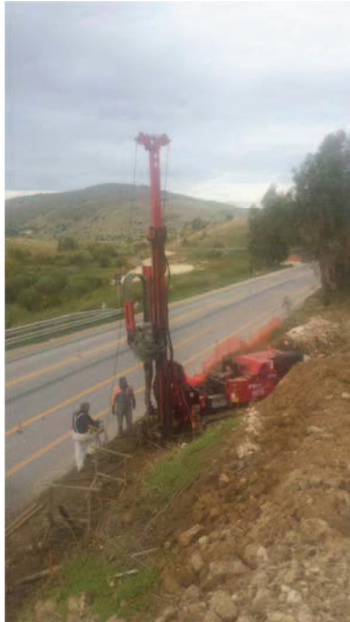
Foto N°16: Postazione sondaggio S4 OS09
