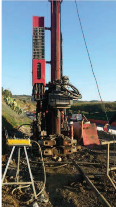
Foto N°19: Postazione sondaggio S5 OS03
