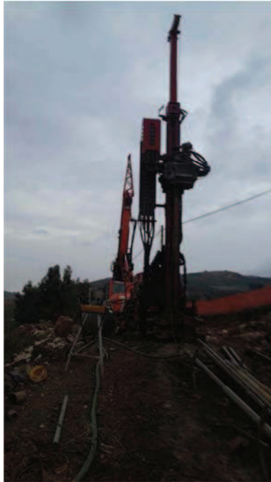
Foto N°6: Postazione sondaggio S2 OS09 Palo 33
