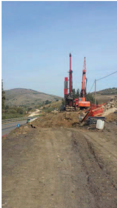
Foto N°12: Postazione sondaggio S3 OS09 Palo 23
