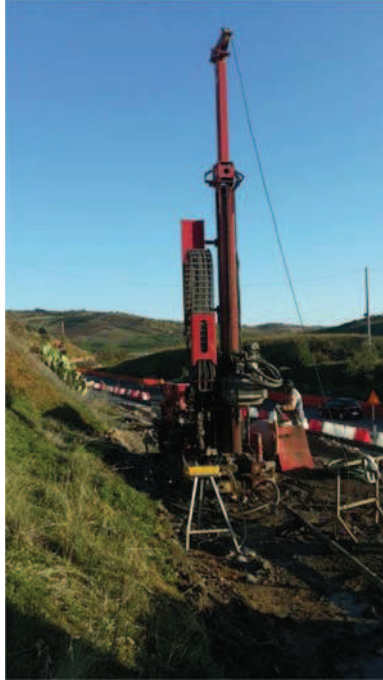
Foto N°1: Postazione sondaggio S1 OS05
