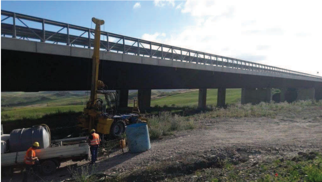
Foto Né1: Postazione sondaggio BH6
