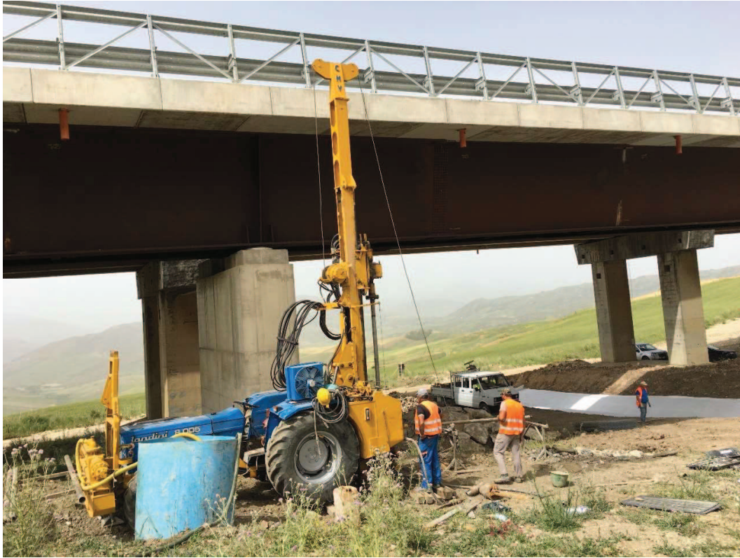
Foto Né1: Postazione sondaggio BH7
