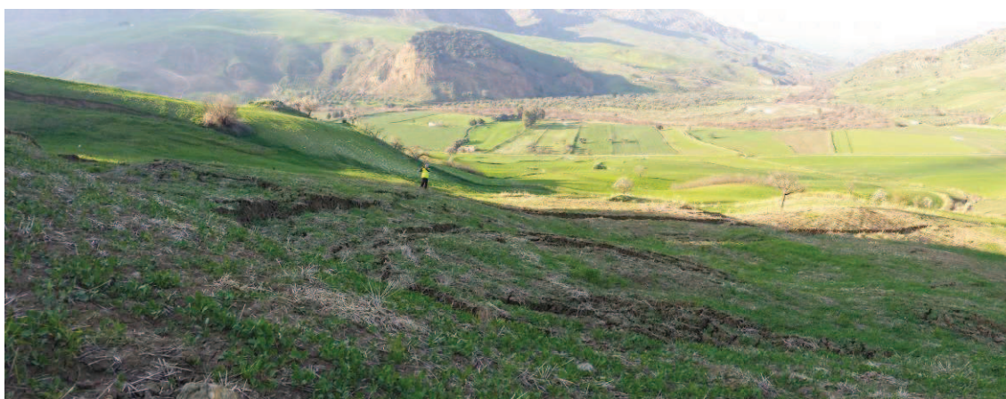
Figura 8: PK 25+917, VIADOTTO ESISTENTE VE10 – FERRUZZE 1. Evidenze di dissesto a valle del viadotto.
