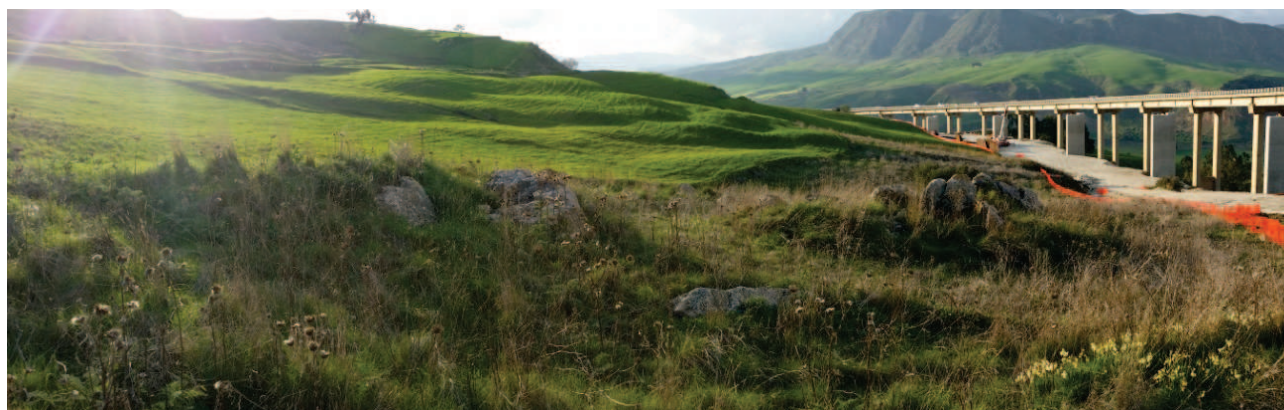
Figura 10: PK 25+917, VIADOTTO ESISTENTE VE10 – FERRUZZE 1. Evidenze di dissesto a monte del viadotto.
