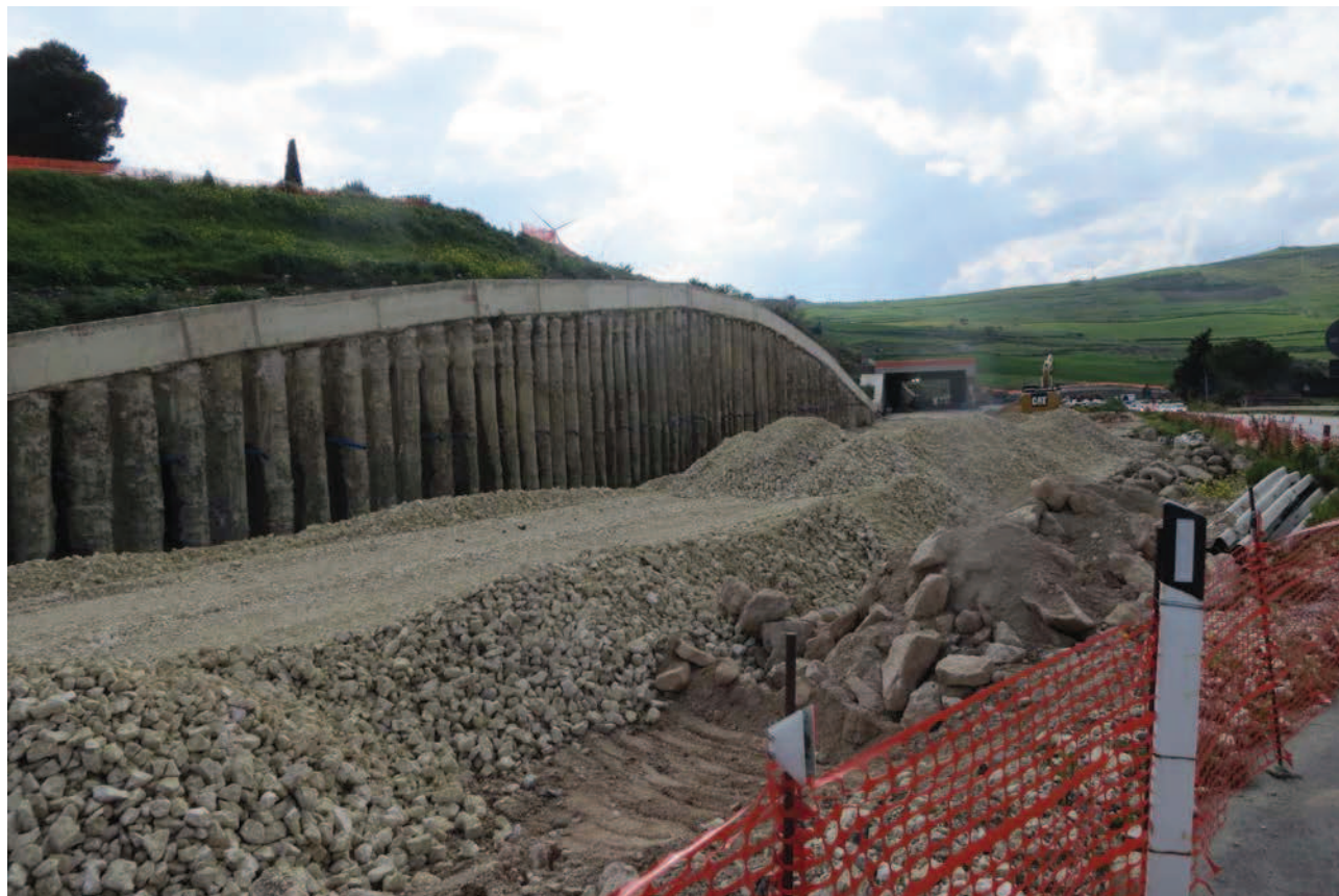
Figura 47: PK 31+518, OPERE OS45B, GALLERIA SAN GIORGIO GA01 E OS46. Vista generale in direzione Palermo
