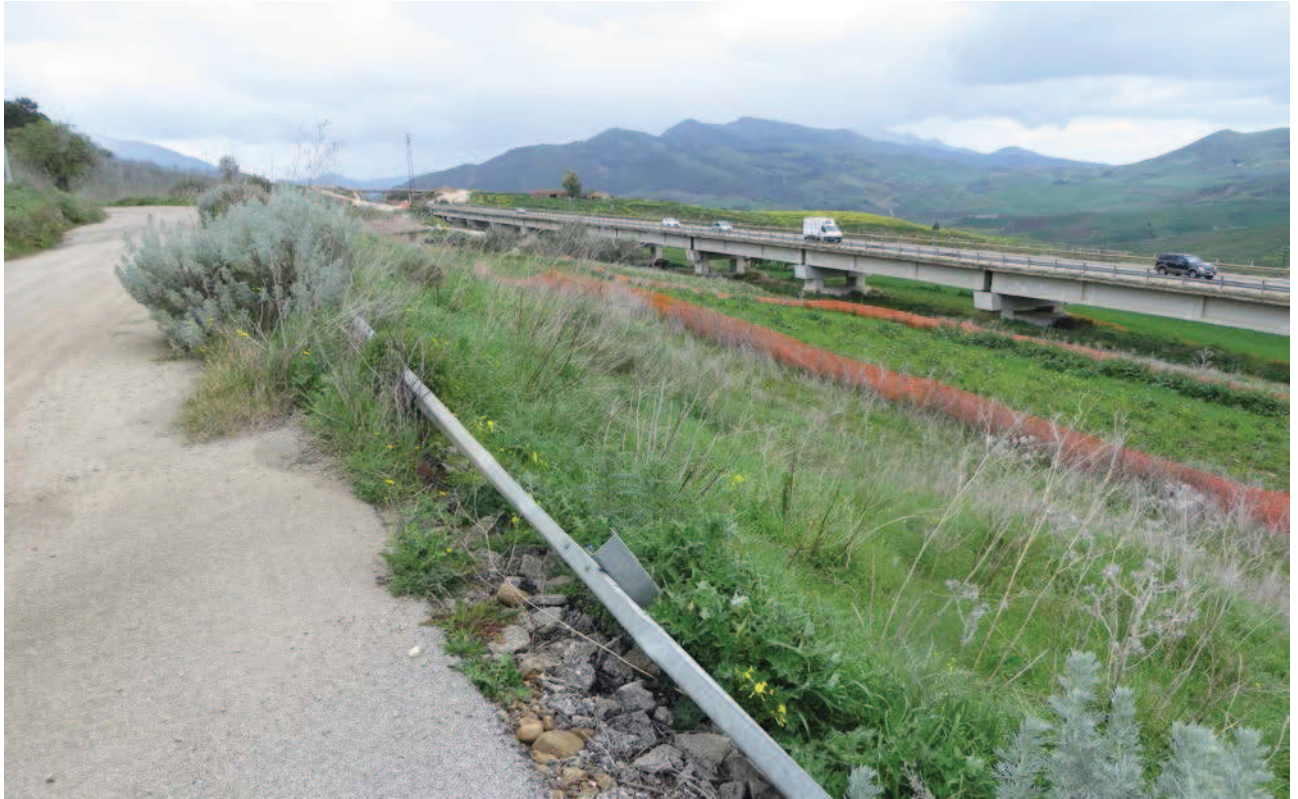
Figura 20: PK 28+981, OPERA OS39 E VIADOTTO ESISTENTE VE12 S.MARIA 2. Vista da monte del viadotto
