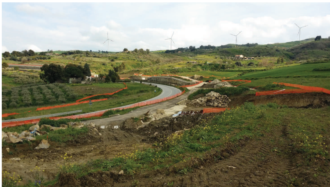
Figura 38: PK 31+087. Foto panoramica dell'area di impianto
