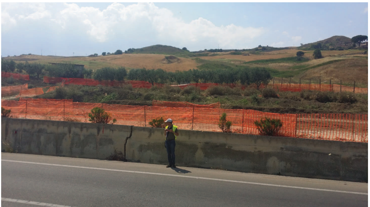
Figura 28: PK 30+357. Evidenze di dissesto sul muro di monte del tracciato stradale attuale.
