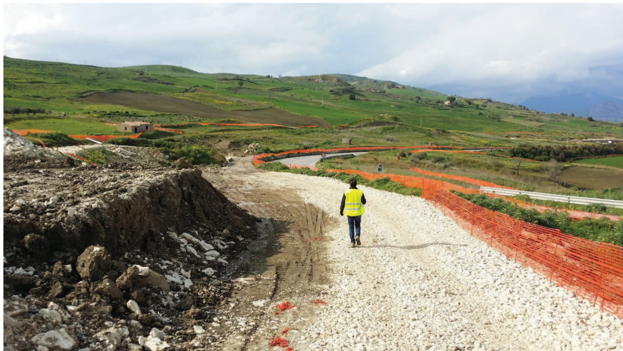
Figura 37: PK 31+087. Foto panoramica dell'area di impianto
