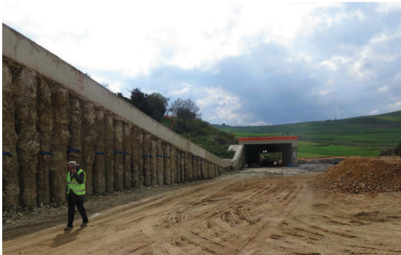
Figura 46: PK 31+518, OPERE OS45B, GALLERIA SAN GIORGIO GA01 E OS46. Vista generale in direzione Palermo
