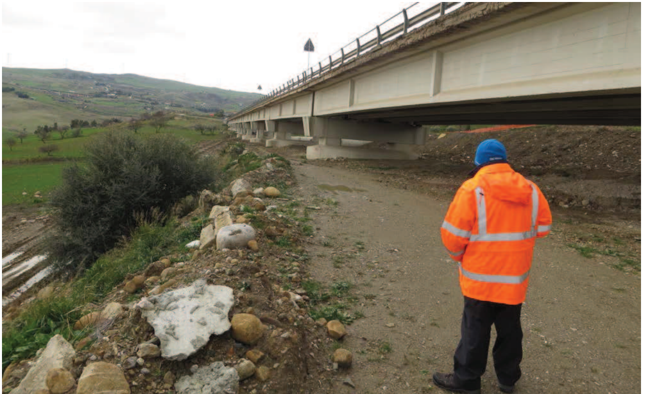
Figura 21: PK 28+981, OPERA OS39 E VIADOTTO ESISTENTE VE12 S.MARIA 2. Vista a valle del viadotto
