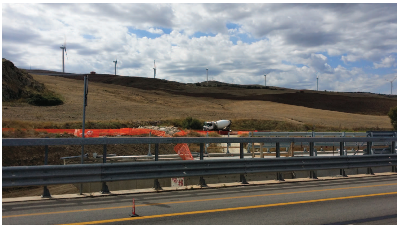
Figura 52: PK 32+474, VIADOTTO ESISTENTE VE15 – MONTAGNOLA 1 E NUOVO VIADOTTO VN05. Porzione di versante a monte del viadotto esistente Montagnola 1
