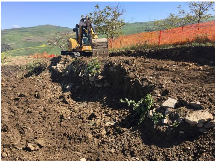
Fig. 9. L'area di scavo durante la rimozione del terreno agricolo US 0 con l'escavatore meccanico. Da N
