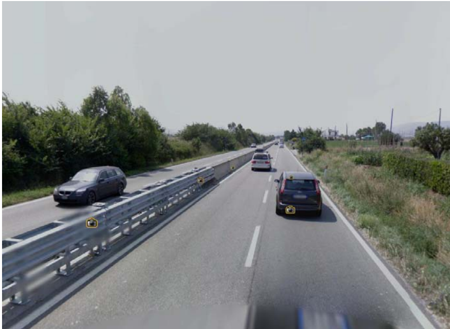
Figura 7: passaggio da barriera di sicurezza metallica a NJ in spartitraffico, dopo Rispecchia
