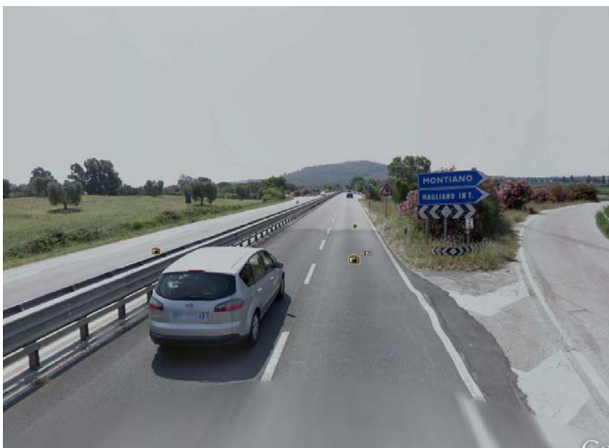
Figura 4: uscita svincolo di Montiano in carr.sud
