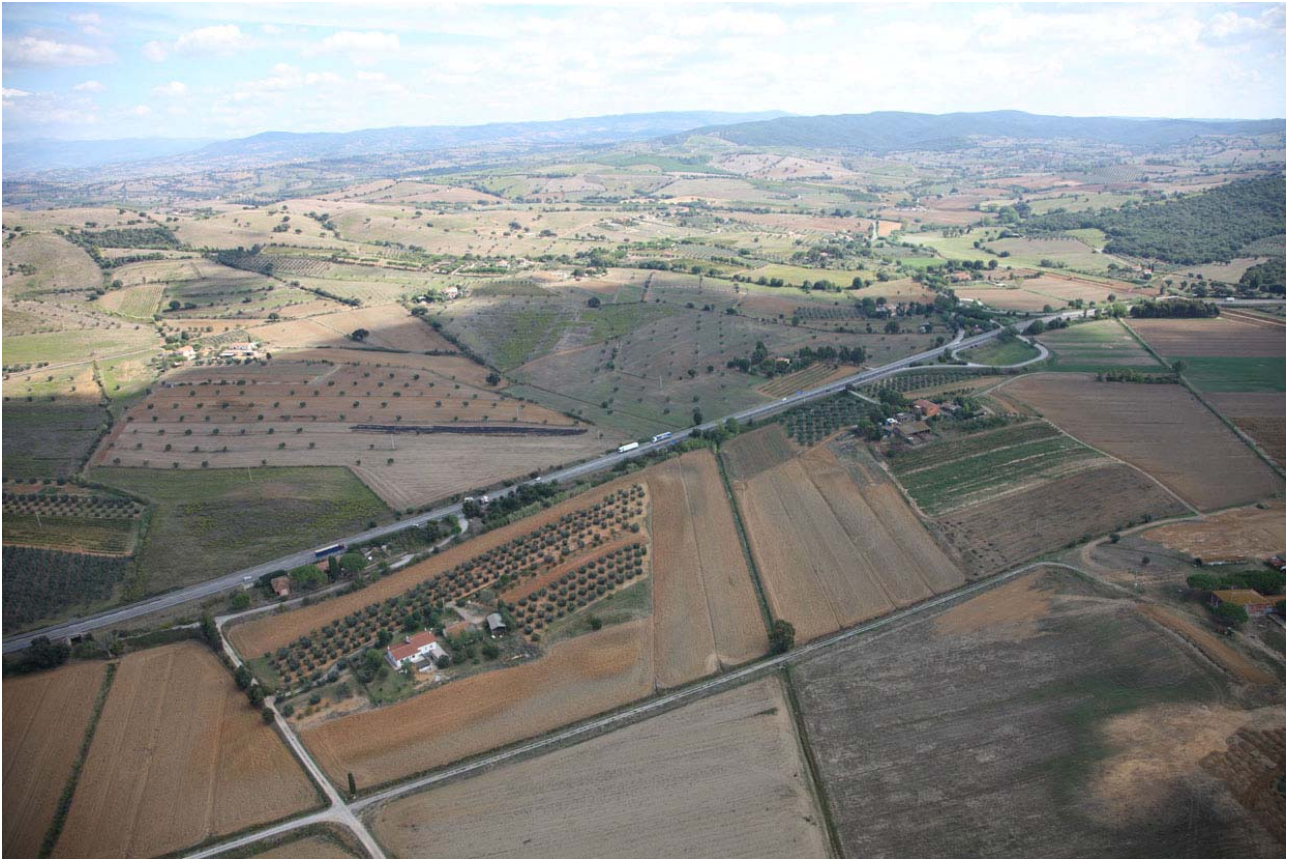
Figura 3: veduta aerea SS1 Aurelia in prossimità dello svincolo di Montiano
