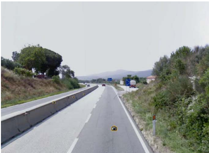
Figura 8: curva sinistrorsa di raggio R=620m , prima del tratto finale in affiancamento alla Linea FS
