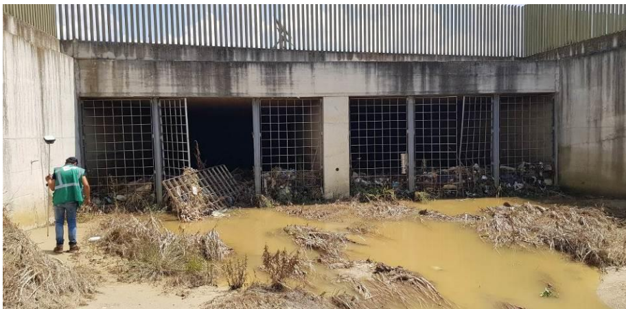
Figura 28 - Imbocco attraversamento Fosso delle Monache
