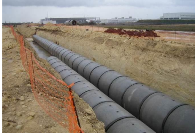
Figura 11 - Individuazione tombamento del Fosso Madonna del Prato in costruzione
