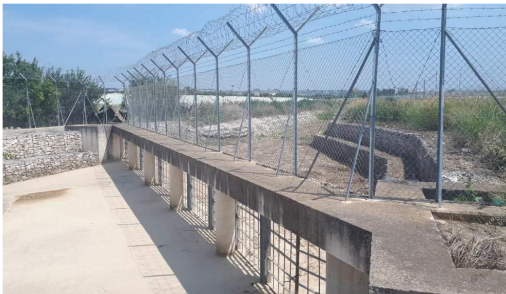
Figura 40 - Fosso Macchione: Cancellate di sicurezza a monte del tombino di attraversamento
