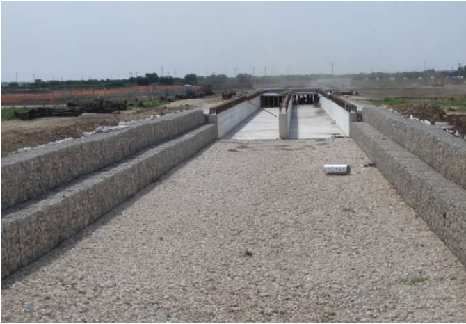
Figura 8 - Tombamento del Fosso Macchione in fase di costruzione
