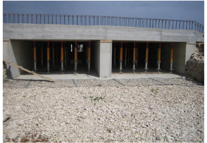
Figura 8 - Tombamento del Fosso Macchione in fase di costruzione
