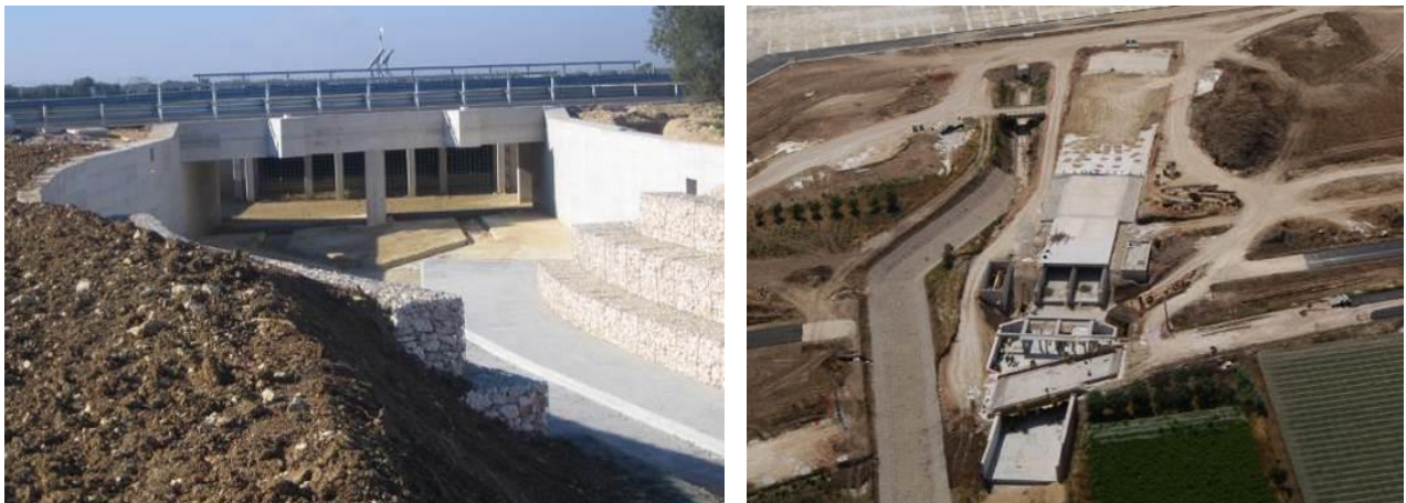
Figura 14 - Individuazione tombamento del Fosso delle Monache in fase di costruzione
