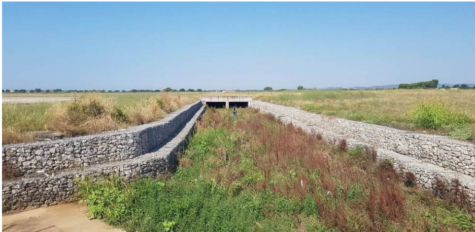
Figura 24 - Tratto di monte dell'imbocco del Fosso Macchione
