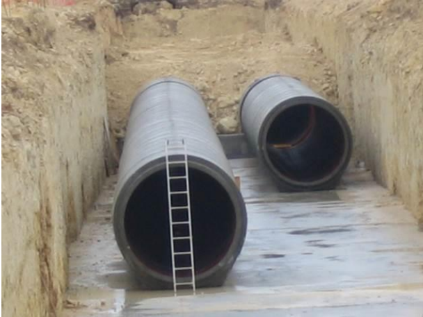
Figura 11 - Individuazione tombamento del Fosso Madonna del Prato in costruzione
