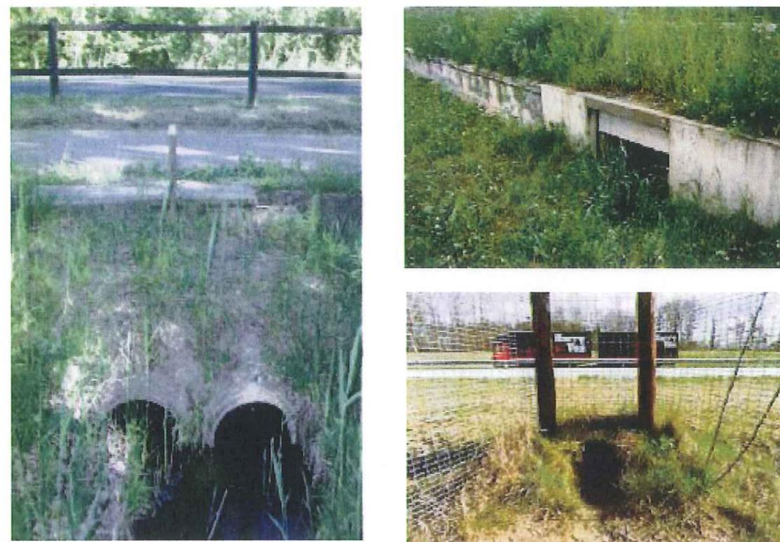
Figura 3. Esempi di sottopassi adeguati per la microfauna.
