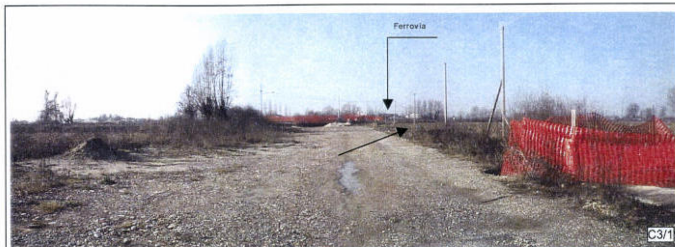
Zona di origine sud della complementare, che gira subito in destra per affiancare la ferrovia (sullo sfondo della foto). L'autostrada transita in viadotto.
