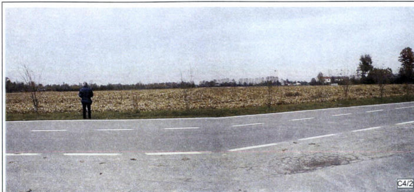
Dalla Via della Rimembranza. Campi aperti in direzione della variante di sovrappasso e, sullo sfondo, verso lo svincolo Martellago.
