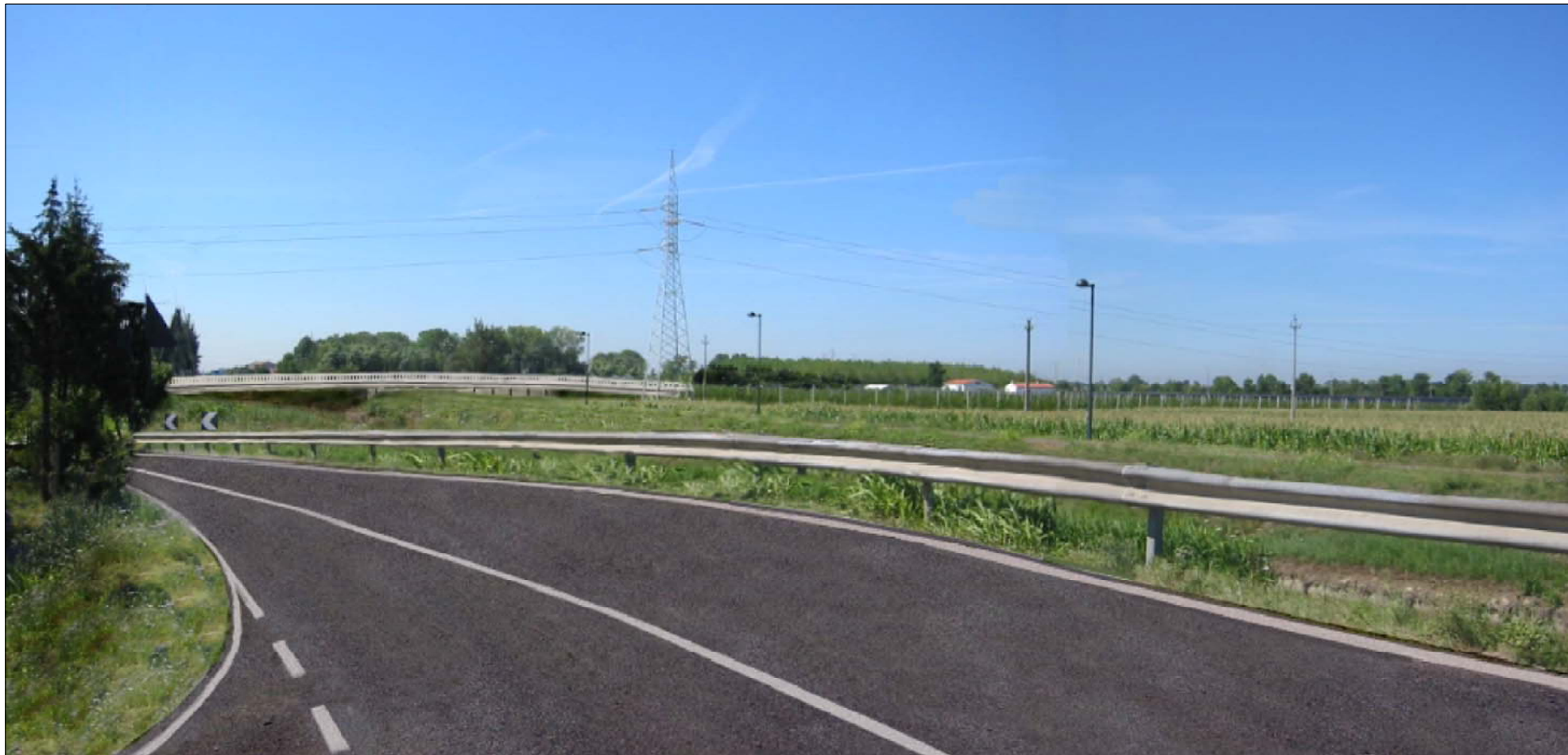
Attraversamento canale Taglio
