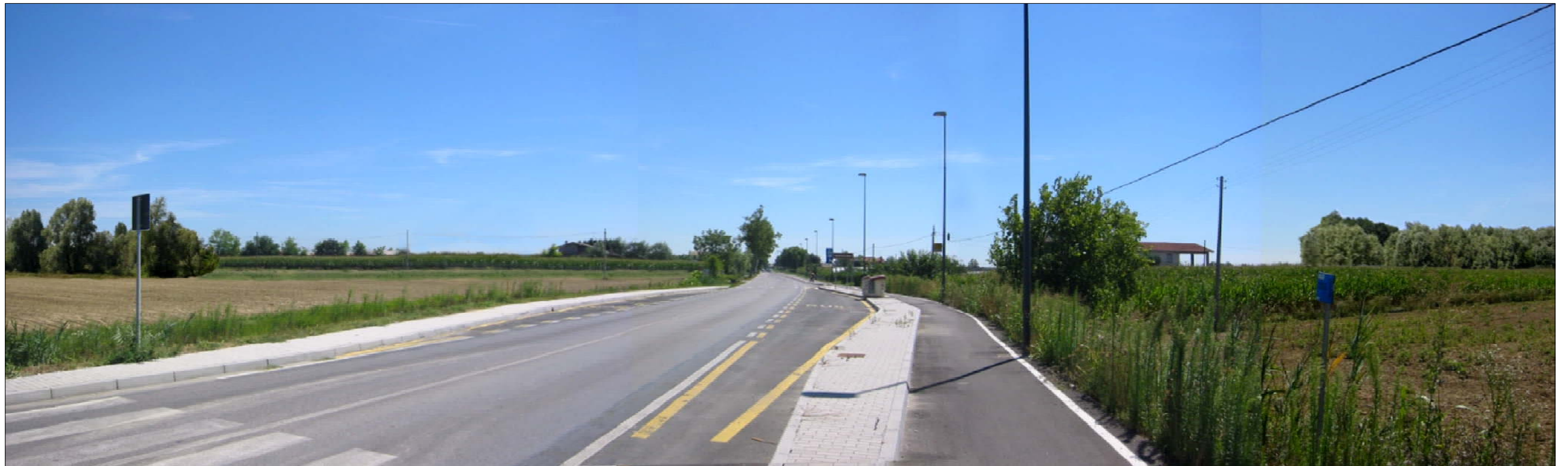
Attraversamento via Nuova Moglianese - loc. Cappella
