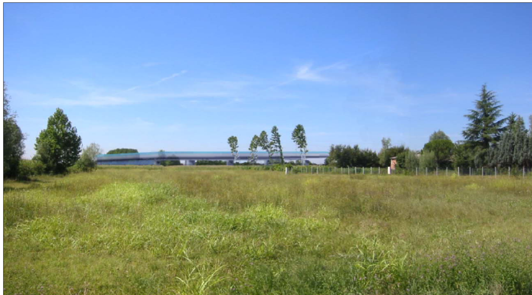
Attraversamento Ferrovia Venezia-Trento
