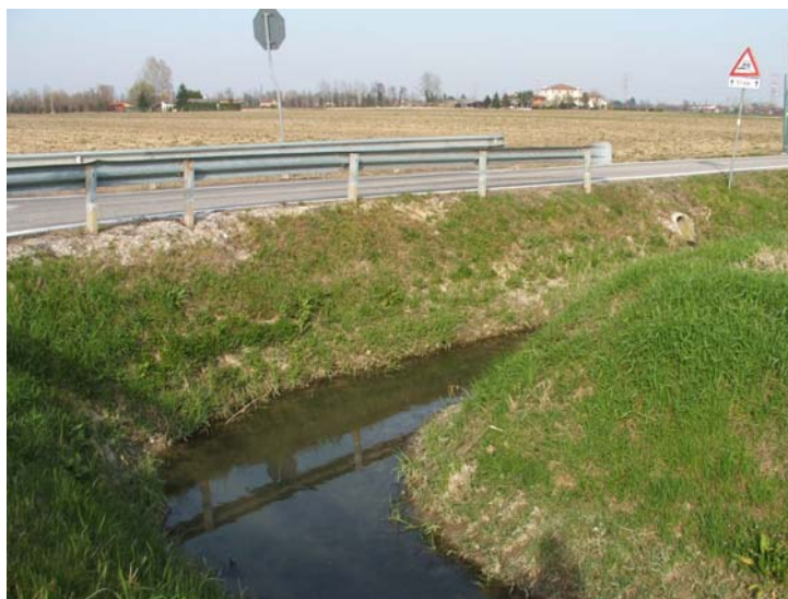
Figura 15- Collettore Tarù all'incrocio fra via Ponte Nuovo e via Tarù
