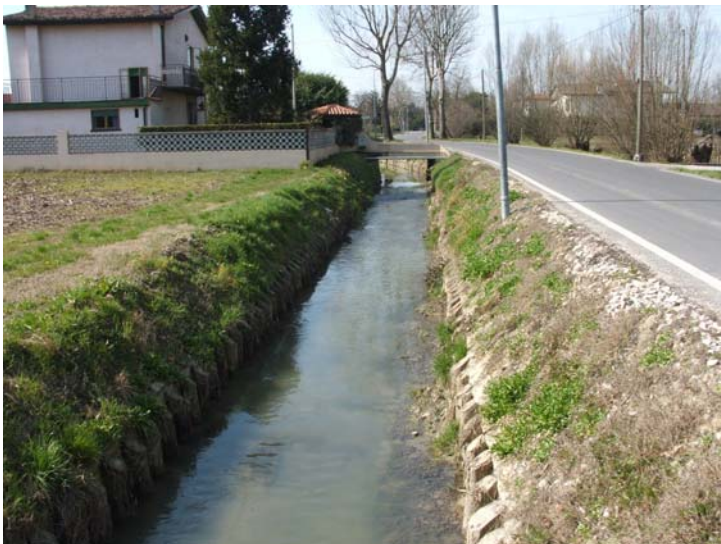
Figura 13- Collettore Bazzera su via Morosini in corrispondenza della galleria in progetto
