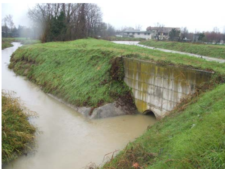
Figura 10- Scarico della botte a sifone e collettore Bazzera (11 dicembre 2008)
