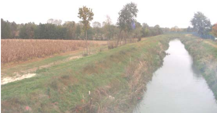
Figura 25- Fiume Dese nei pressi del ponte sul Passante
