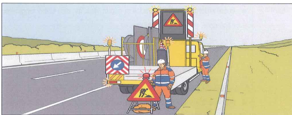
Chiusura della corsia di emergenza: installazione del segnale lavori
