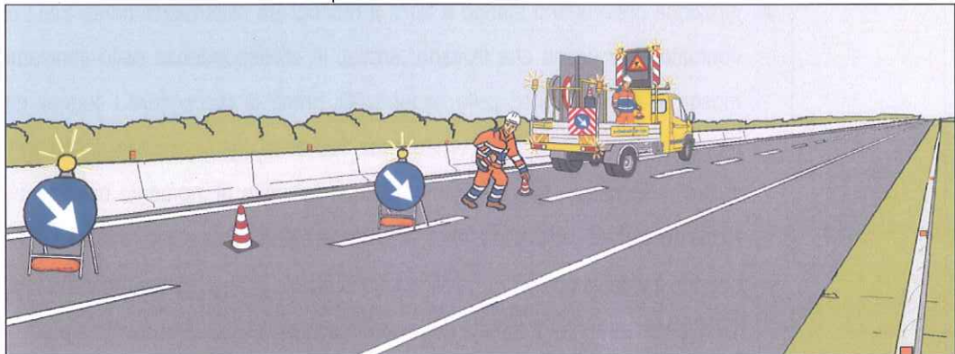
Chiusura della corsia di sorpasso: inizio della posa dei coni
