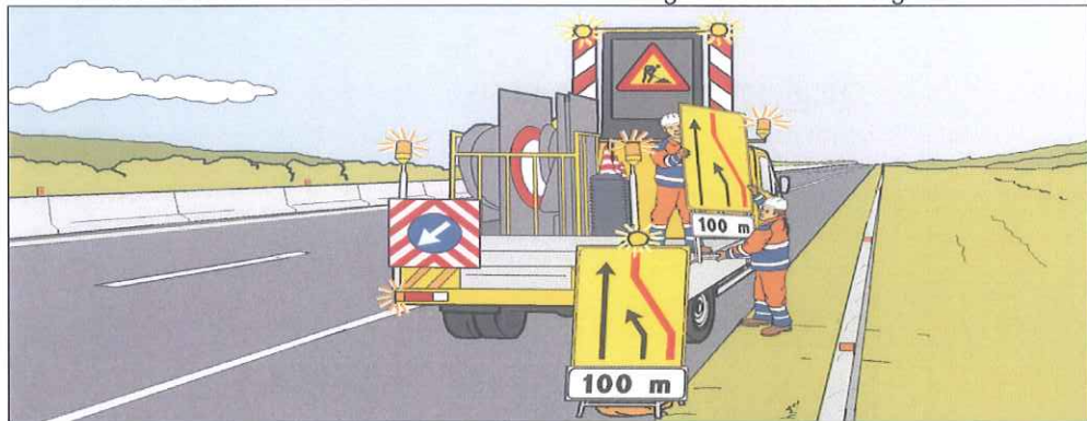
Chiusura della corsia di marcia: scarico e installazione sul margine destro dei segnali di riduzione ad una corsia
