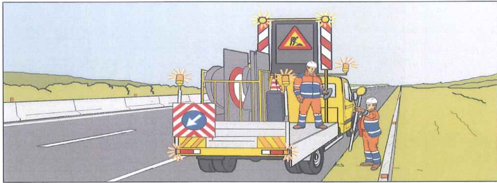
Chiusura della corsia di marcia: scarico della segnaletica dal mezzo
