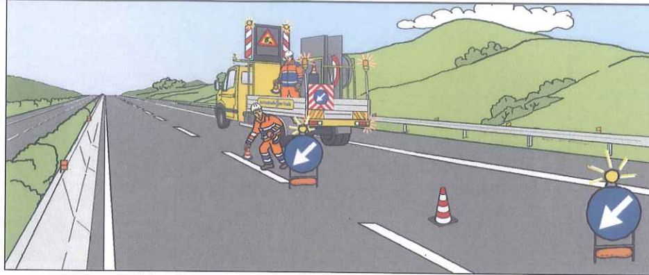
Chiusura della corsia di marcia: inizio della posa dei coni
