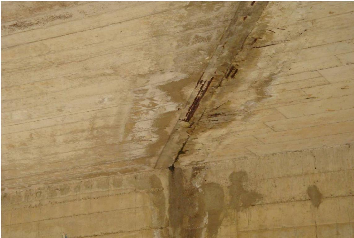
*Foto 4 – Vista intradosso – armature scoperte lungo il giunto*
