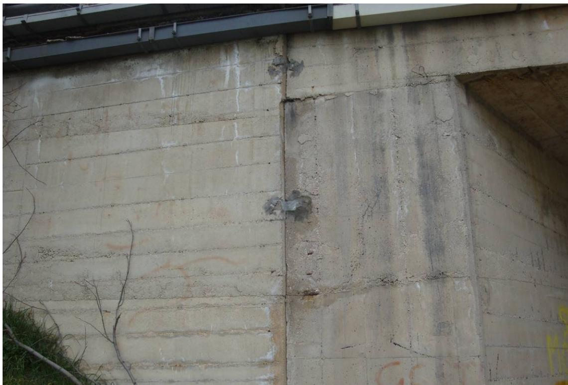
*Foto 4 – Particolare del giunto tra muro frontale e muro andatore
