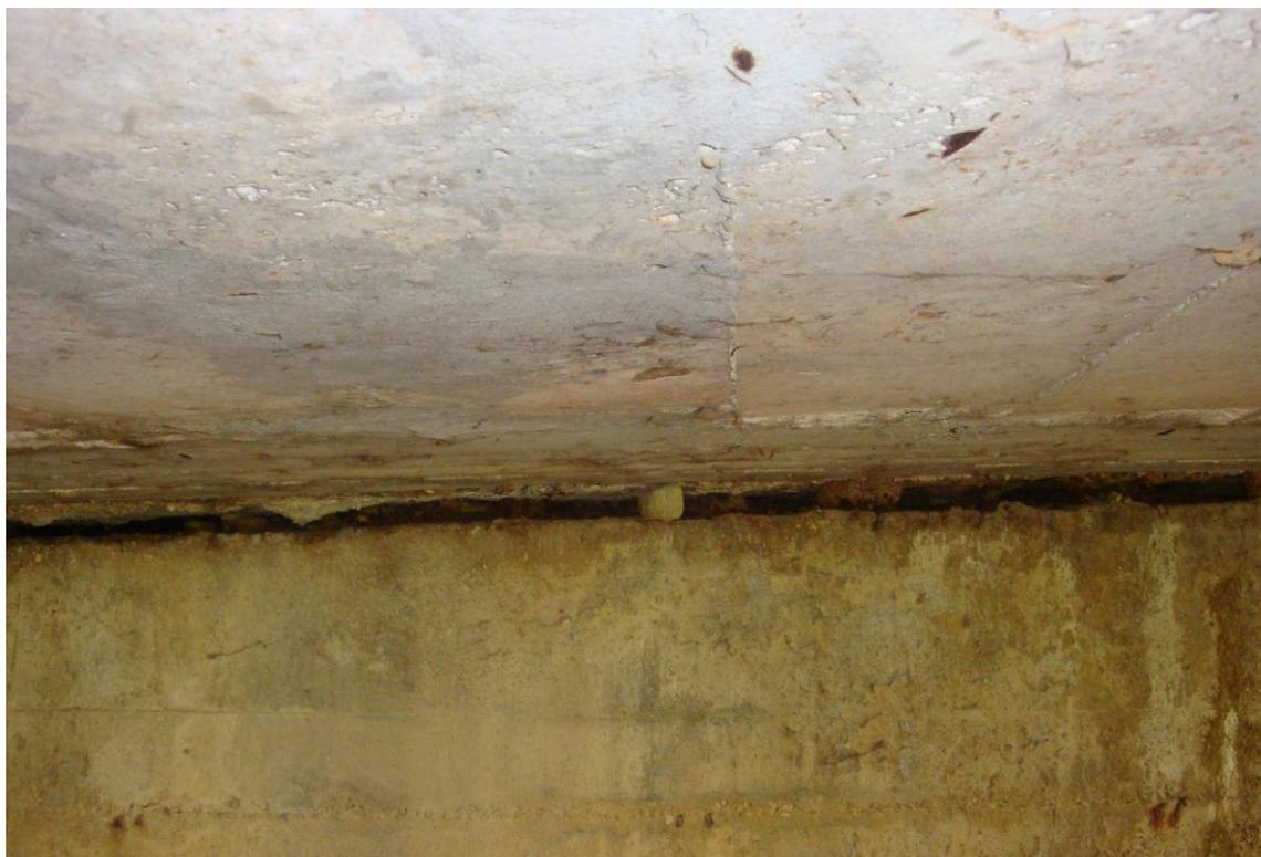
*Foto 7 – Particolare appoggio dell'impalcato sulla spalla*
